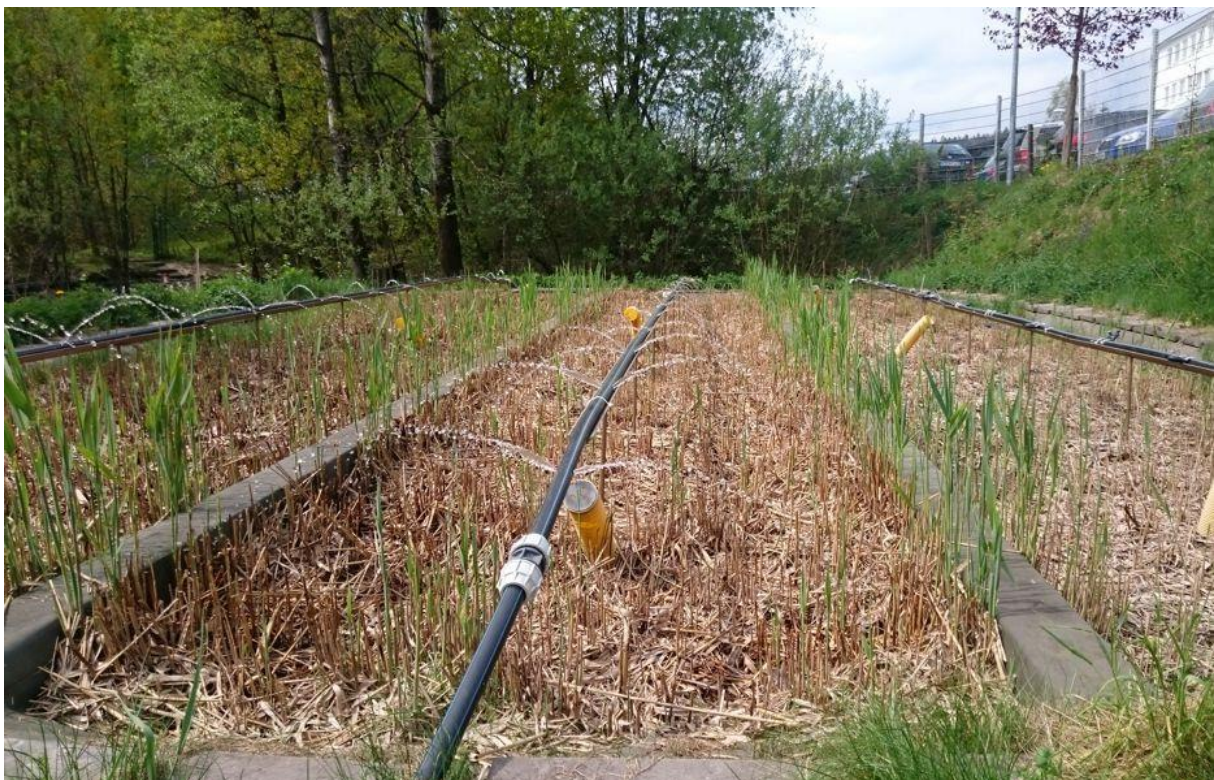
Abb.4: Bewachsener Bodenfilter (Pka), Beschickung über Bohrungen (Frühjahr)
