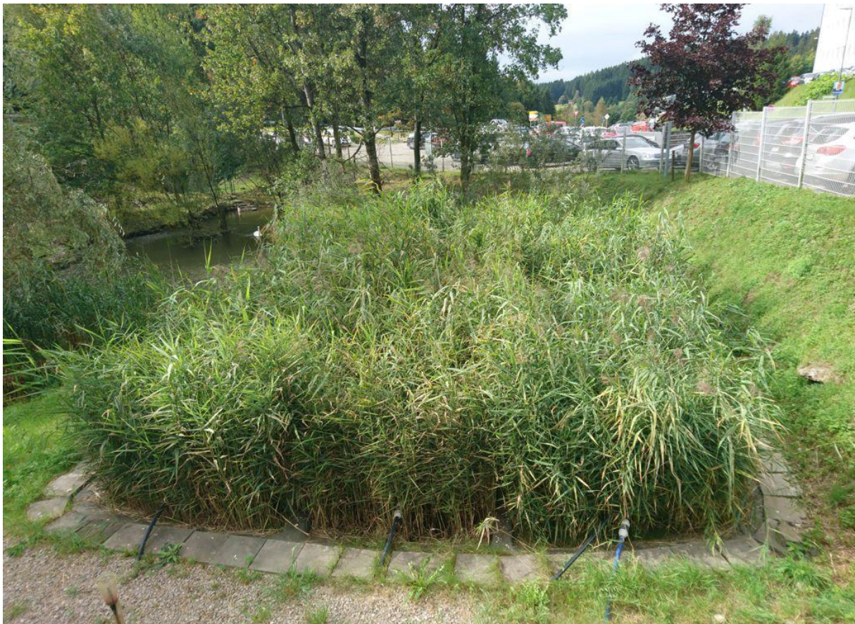
Abb. 1: Foto Versuchsanlage mit Umfeld (Quelle: K. Holzapfel)
