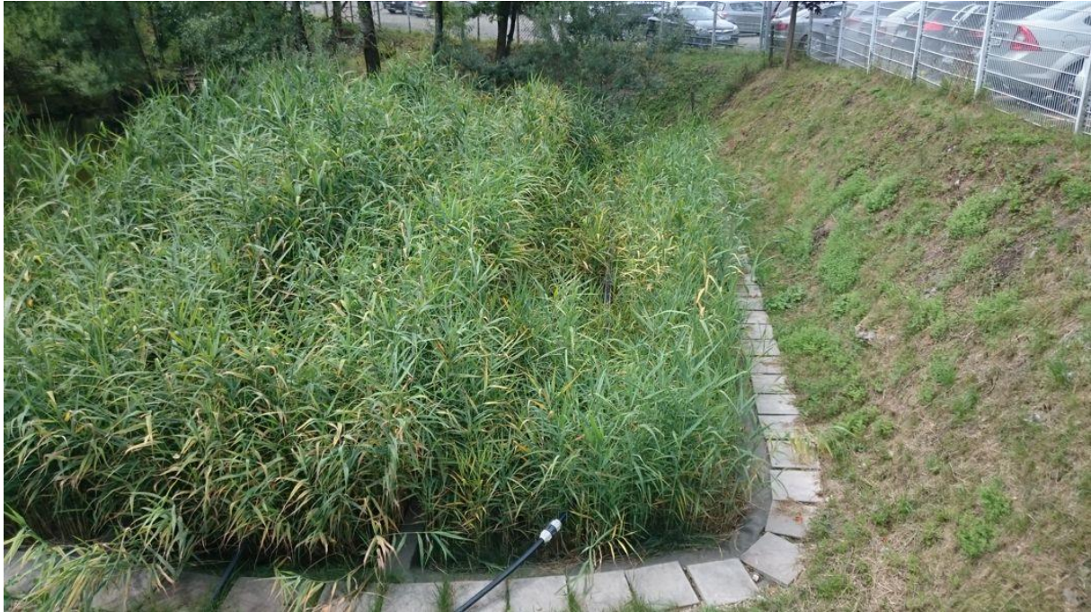
Abb.3: Bewachsener Bodenfilter (Pka), Pilotanlage der Fa. Heinz Glas in Kleintettau (Frühsommer)
