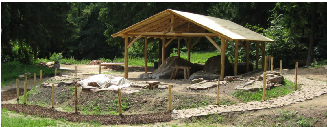
Abb. 3 Wiederherstellung der Ofenrelikte der Glashütte am Lakenteich (Solling) im Juli 2010. Unter dem Schutzdach das weitgehend erhaltene Fundament des Hauptofens
