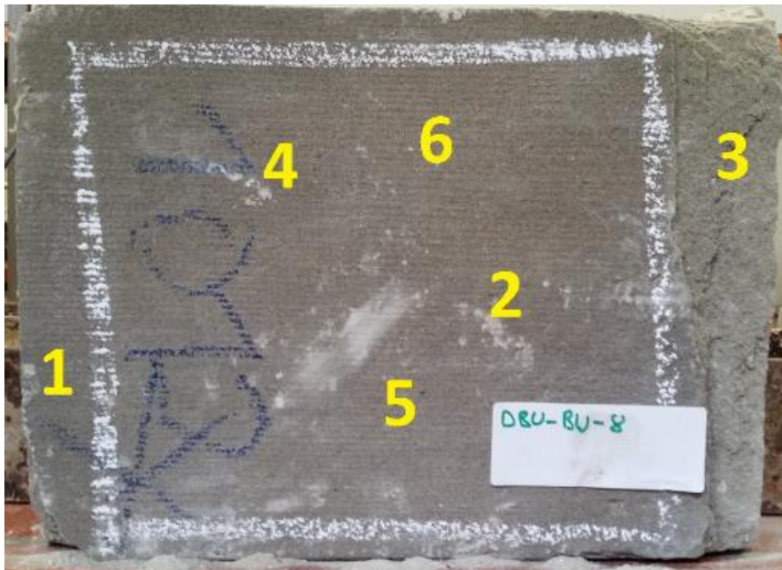
Abb. 15: Ansicht der Probe DBU-BW 8 mit eingezeichneten Bohrmessstellen 8-1 bis 8-6. Bereich mit Resthydrophobierung ist weiß markiert (Innenbereich).
