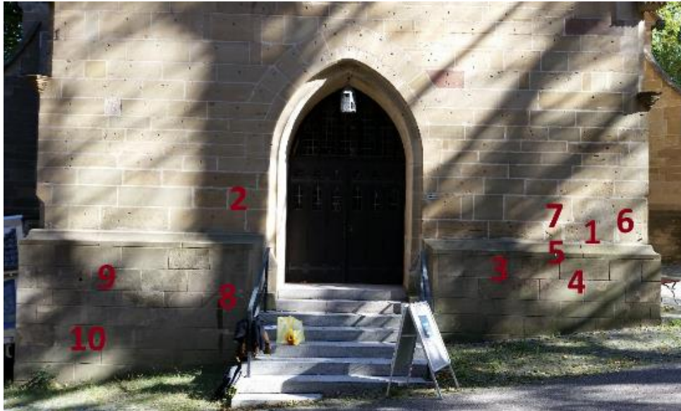
Abbildung 6: Evangelische Michaelskirche Waiblingen– Westfassade mit gekennzeichneten Messstellen.
