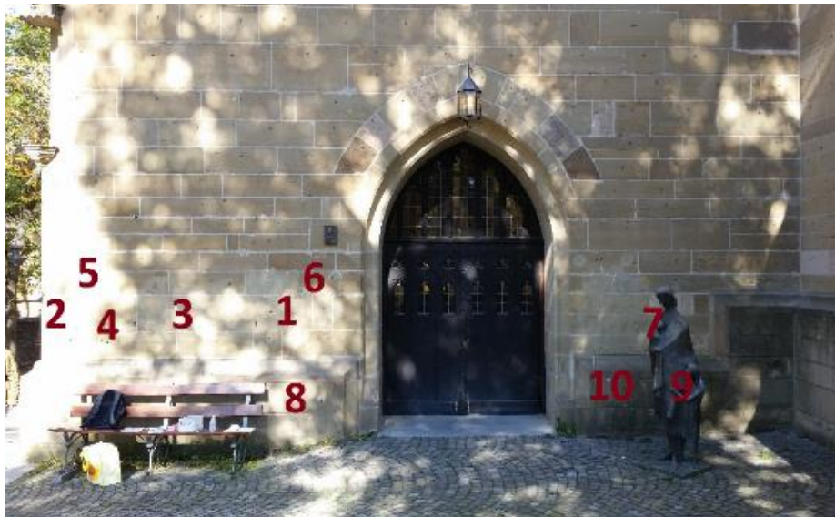
Abbildung 1: Evangelische Michaelskirche Waiblingen– Südfassade mit gekennzeichneten Messstellen.
