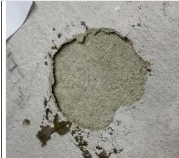
Abb. 3: Haftzugmessung an Probe DBU-BW-P1 im Bereich einer vorhandenen Schale.
