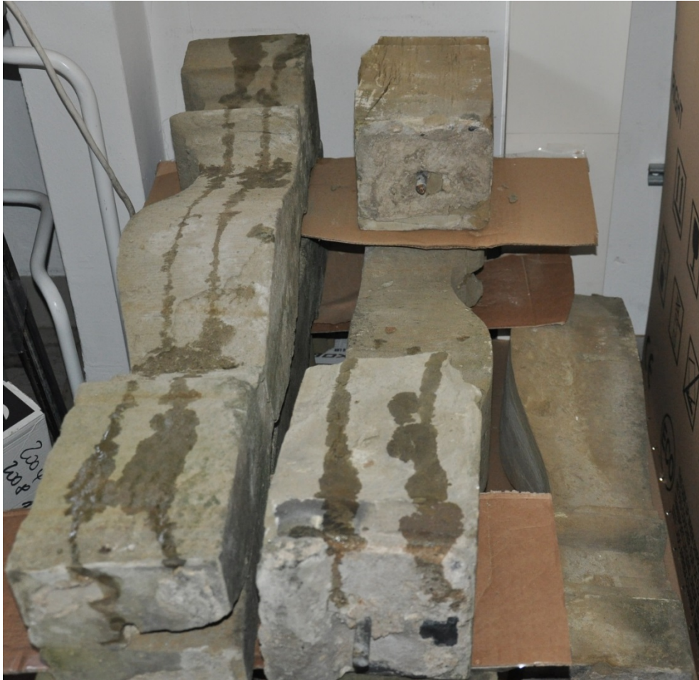
Abb. 2 Projektproben - Ansicht der Ausbauteile (Oktogon-Balustrade) der Kirche Neuenstein nach einfachem Wassertest auf Hydrophobie im HFT-Bauchemielabor. Fazit: Bei gleichförmiger Benetzung zeigen die drei Balustradenteile mit Altbehandlung unterschiedliche Wasseraufnahme.
