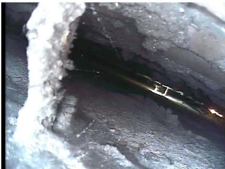
**Abb. 17:** Blick hinter die Vorgestellte Wand, auf der sich das Crodell-Gemälde befindet, von oben nach unten; ganz rechts unterhalb der Bildmitte ist eine Lichtquelle zu sehen, die durch eine Belüftungsöffnung im Sockelbereich in den Zwischenraum geschoben wurde. Links daneben befindet sich ein LED-Streifen, der als zusätzliche Lichtquelle von oben herabgelassen wurde. Im Vordergrund links und nahe des LED-Streifens sind korrodierte Abstand-Eisen zu sehen.
