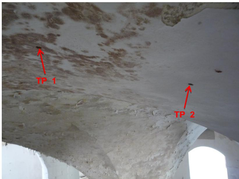
Abb. 11: Musterfläche 9 an der Decke der Crodellhalle, die Pfeile lokalisieren die Tiefenprofile im belasteten und unbelasteten Bereich
