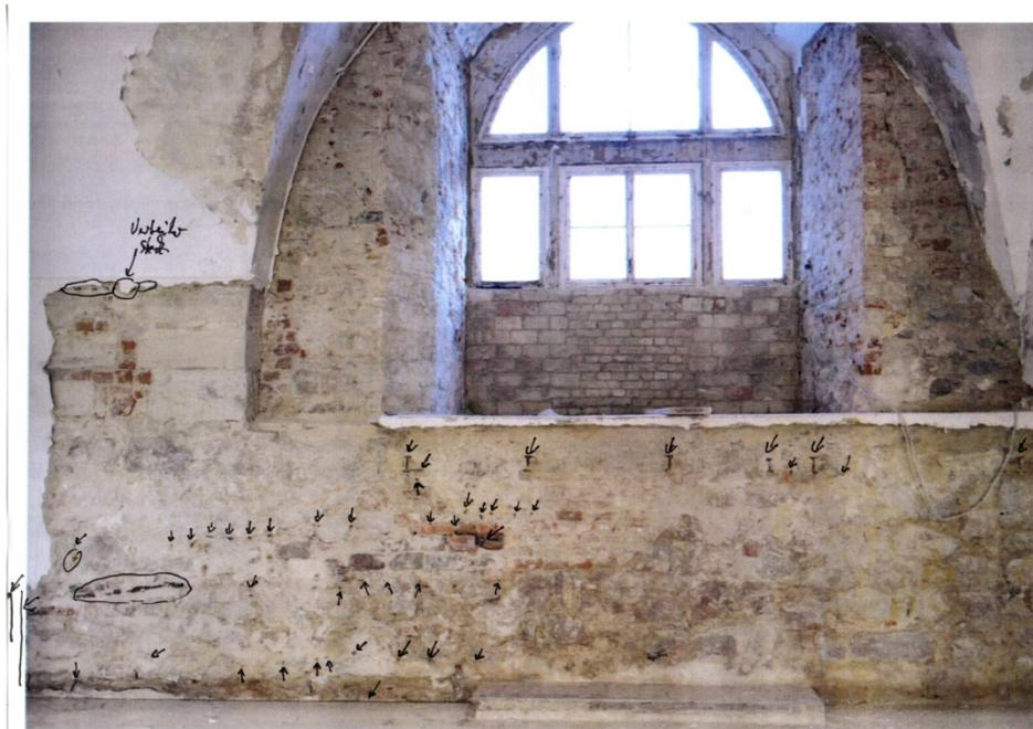
**Abb. 53:** Halle, Moritzburg, Crodellhalle, Ostwand, „Voruntersuchungsfläche 5“, Kartierung im Mauerwerk befindlicher Eisenteile im Vorfeld der Anlage von Putzmusterflächen
