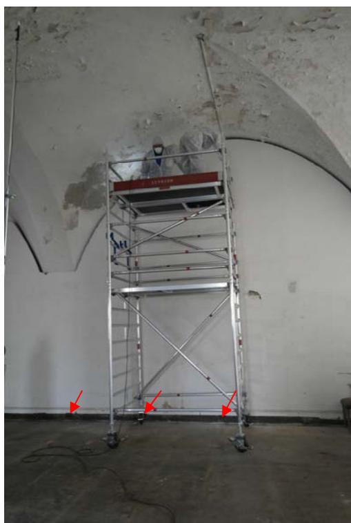
**Abb. 16:** Vorgestellte Wand auf der sich das Crodel-Gemälde befindet; die Pfeile markieren die Lüftungsöffnungen im Sockelbereich
