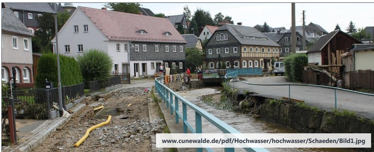
Abb. 11: Cunewalde – zerstörtes Deckwerk und beschädigte Stützmauern am westlichen Erlenweg
