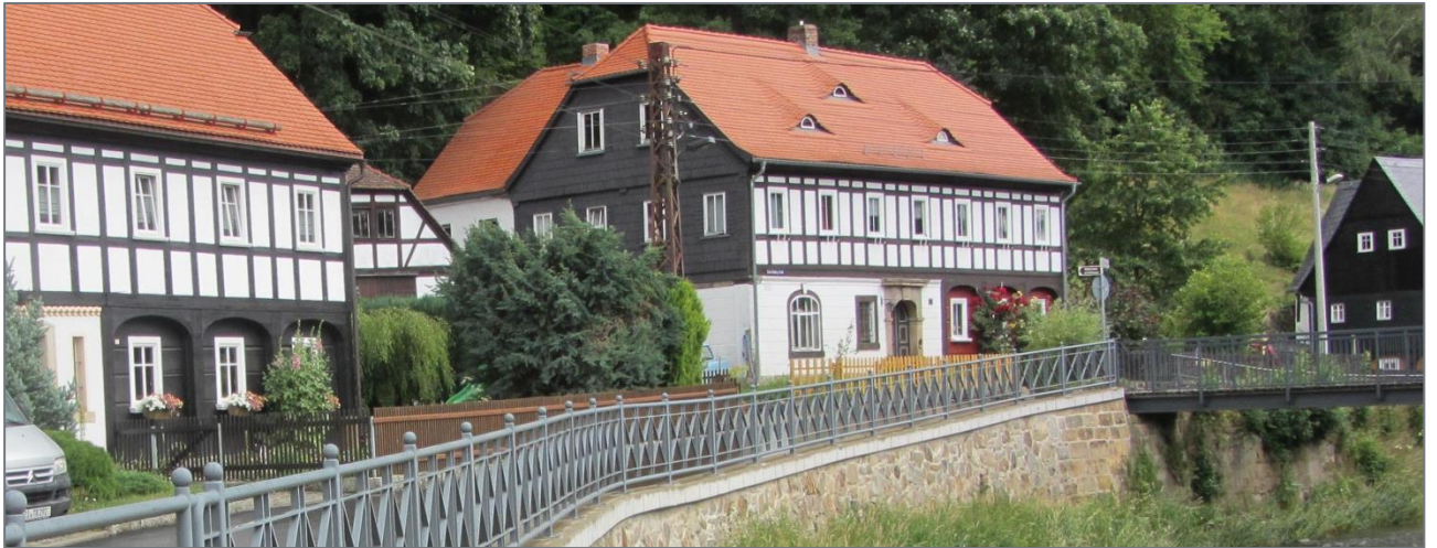
Abb. 13: Großschönau – nach Gestaltungskonzept wieder aufgebautes Teilstück im Kernbereich
