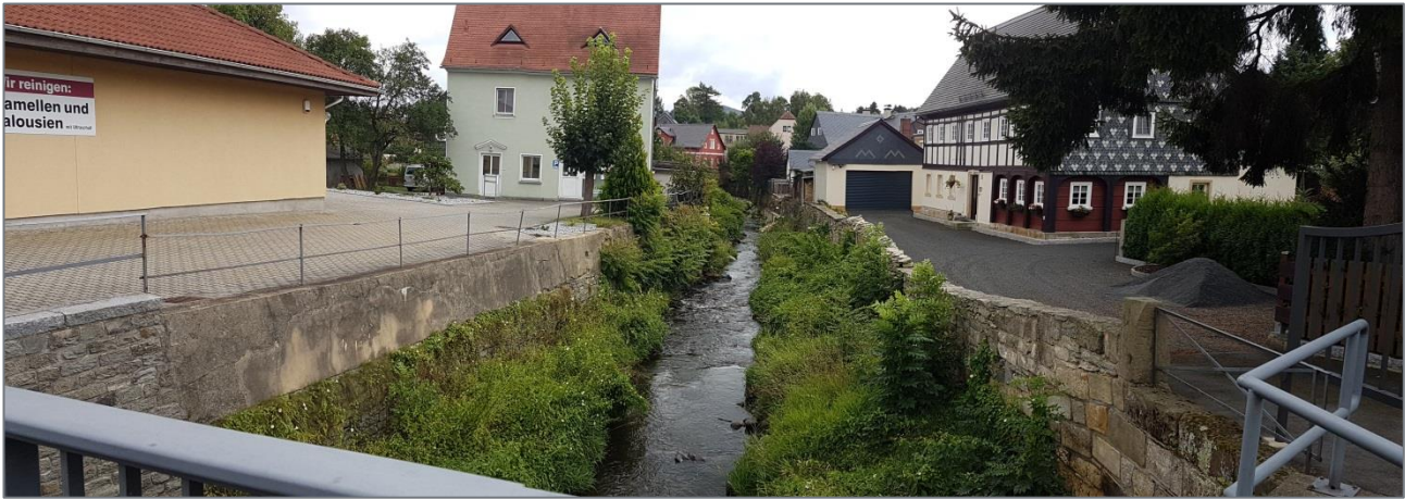
Abb. 21: Großschönau – Stützmauer entlang der Lausur in Höhe „Waltersdorfer Straße 3a“
