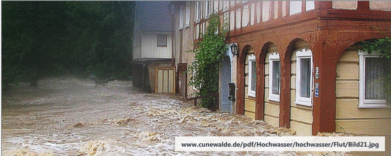
Abb. 9: Cunewalde – Hochwasser am 7. August 2010 mit überflutetem Umgebendehaus
