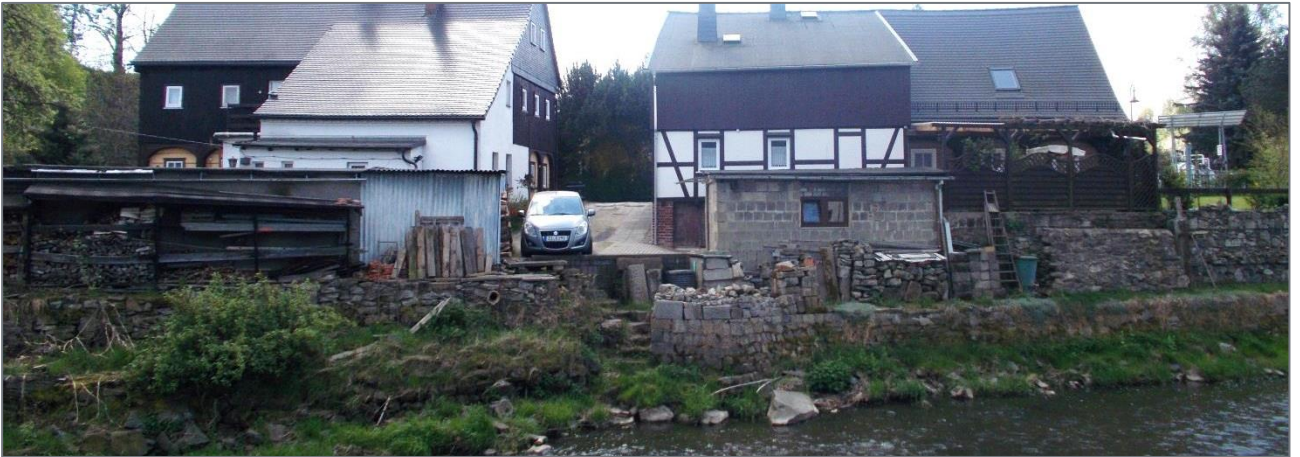
Abb. 24: Großschönau – Stützmauern an der Mandau in Höhe „Am Damm 7-11“
