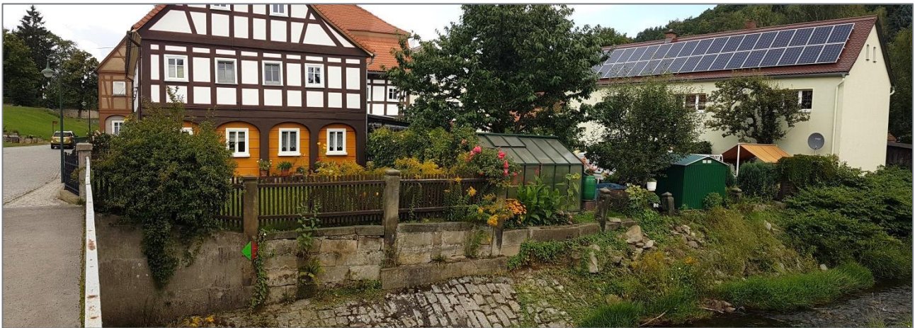
Abb. 22: Großschönau – Stützmauer entlang der Lausur in Höhe „Theodor-Haebler-Straße 19“
