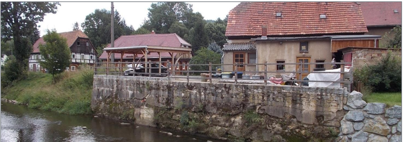
Abb. 25: Hainewalde – Stützwand entlang der Mandau in Höhe „Talstraße 6“
