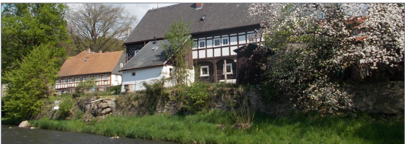
Abb. 23: Großschönau – Stützmauer an der Mandau in Höhe „Dr.-Külz-Straße 2“
