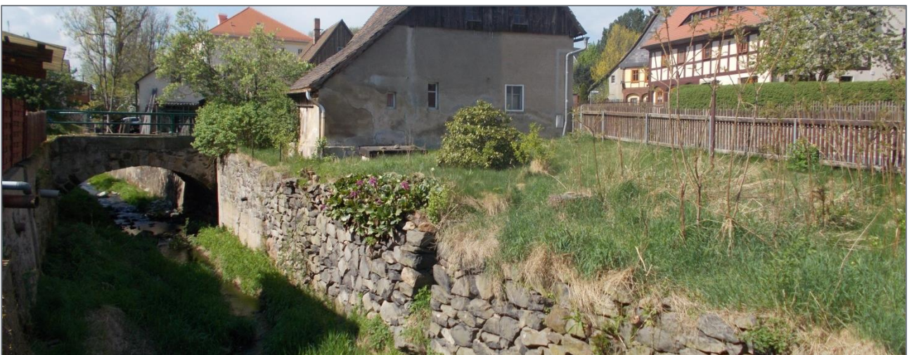
Abb. 26: Bertsdorf – Stützmauer am Bertsdorfer Wasser in Höhe „Hauptstraße 30“
