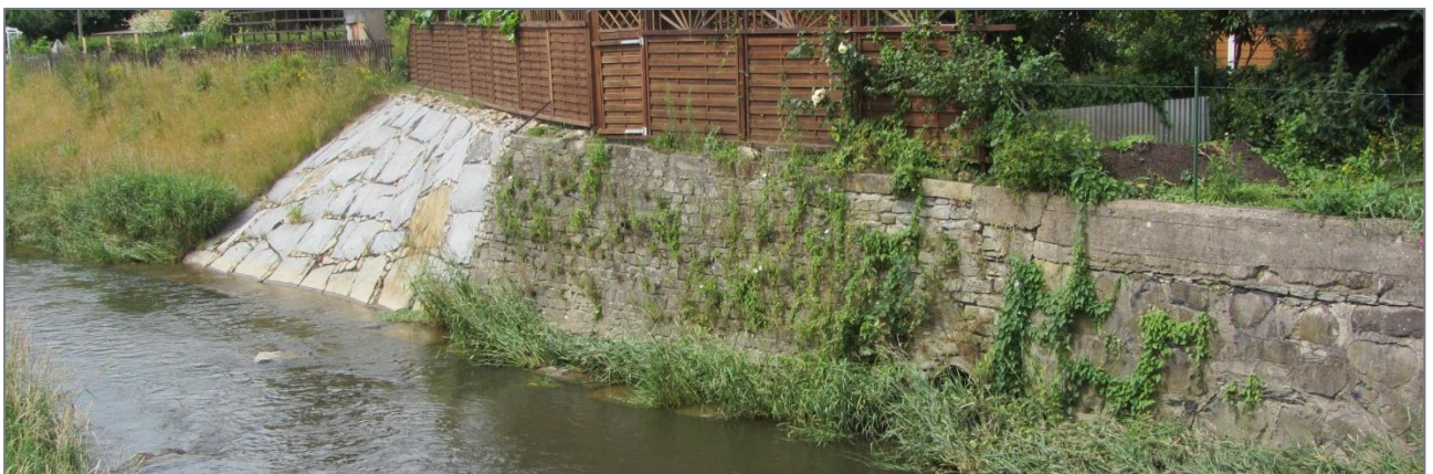
Abb. 15: Beispiel für Inhomogenität hinsichtlich des optischen Erscheinungsbildes von Stützmauern
