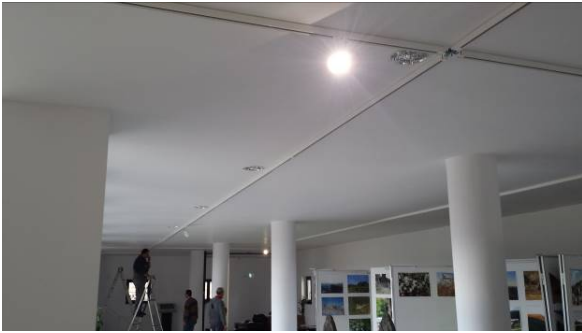
Foto 34: Installation der Beleuchtung auf Schienen.
