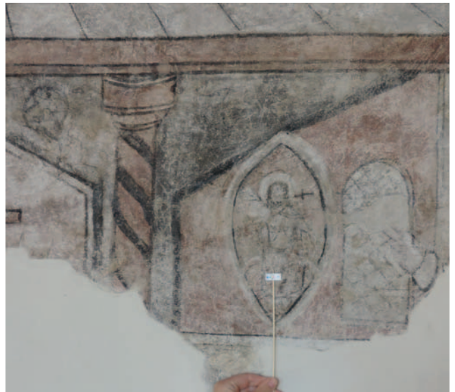
Abb. 21: Prenzlau, Dominikanerkloster, Gästerefektorium, Südwand, unter Geislung, Lokalisierung des Messpunktes N° 175 (RFA)
