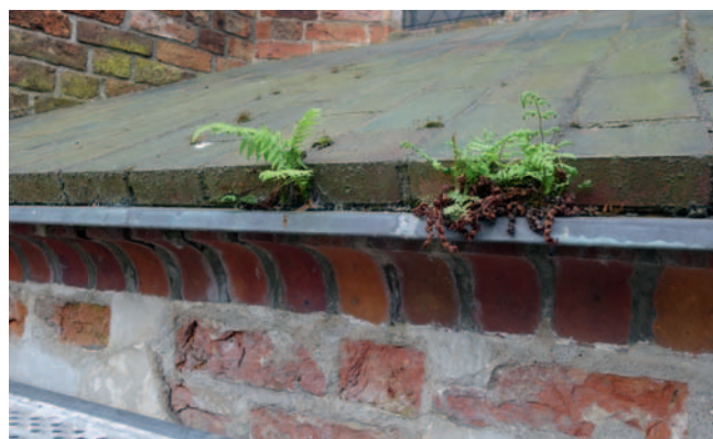
Abb. 4: Frankfurt (Oder), Marienkirche, Außenansicht der Nordvorhalle, Detail der Dachabdeckung, Zustand vor der Instandsetzung, Foto: Jan Raue 2015
