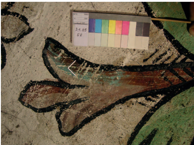
Abb. 25: Hz 4/19. Verblaute, stellenweise auch verblasste, ehemals braune Malschicht (Pfeilmarkierung). Probenentnahmestelle
