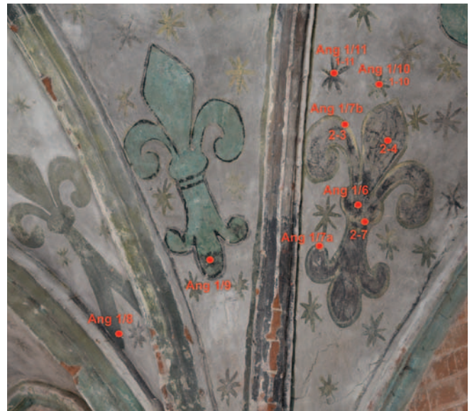
Abb. 8: Angermünde, Franziskanerklosterkirche, Sakristei, Joch II zur Südwestwand, Detail B, Lokalisierung der Messpunkte bzw. der Probenentnahmestellen (RFA, REM/EDX und Raman)
