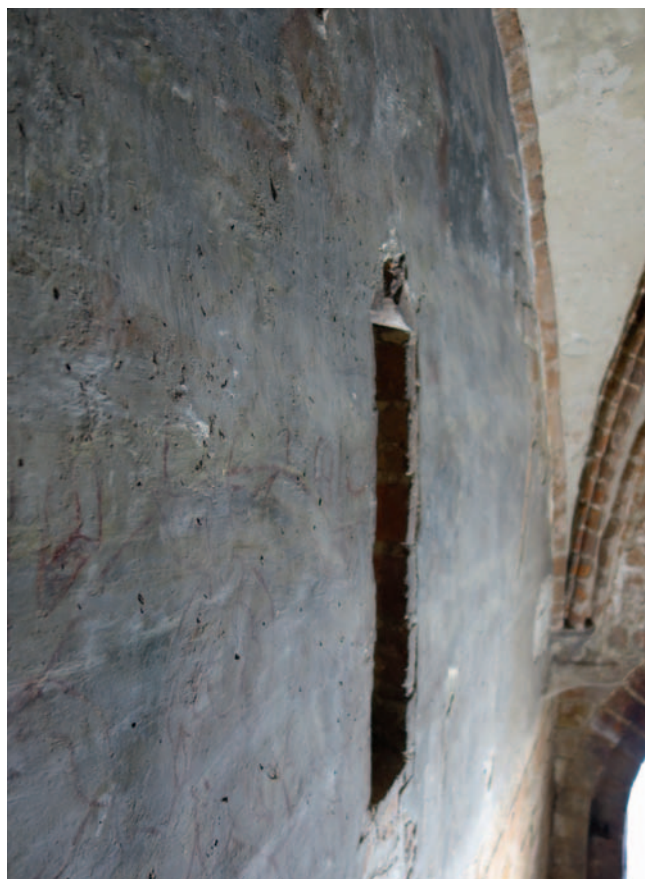
Abb. 4: Chorin, Fürstensaal, Fledermauskot auf der Wandmalerei, Foto: Jan Raue, Juli 2014
