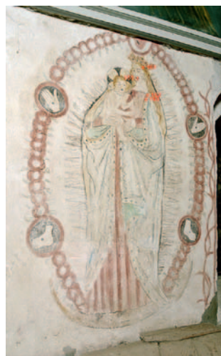
Abb. 17: Lübbenow, Feldsteinkirche, Strahlenkranzmadonna, Lokalisierung der Messpunkte bzw. der Probeentnahmestellen (RFA und REM/EDX)
