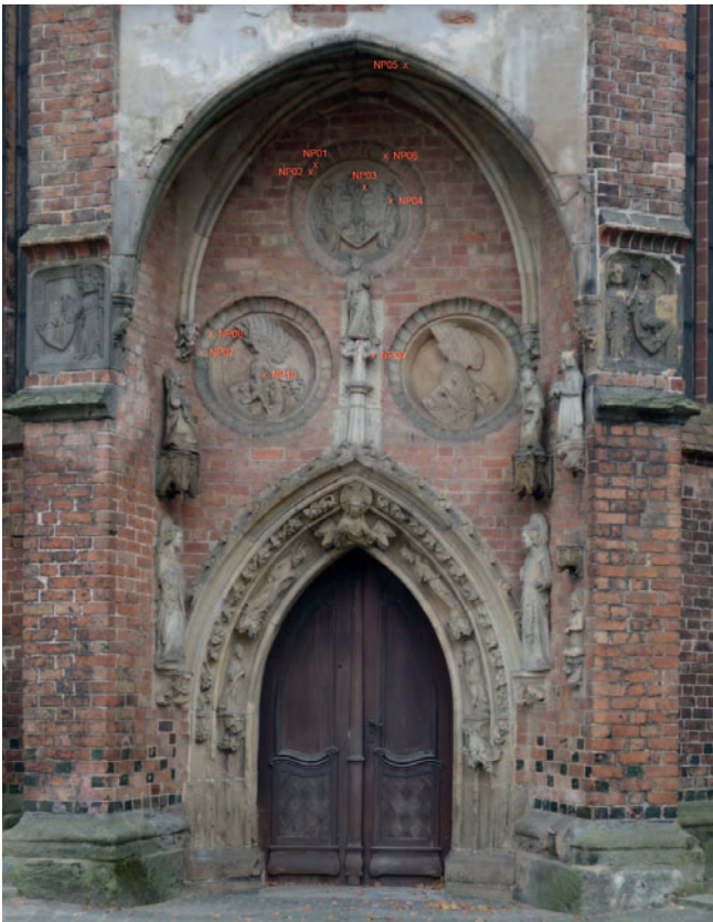
Abb. 3: Frankfurt (Oder), Marienkirche, Nordportal, Lokalisierung der Messpunkte bzw. der Probeentnahmestellen (RFA, REM/EDX)
