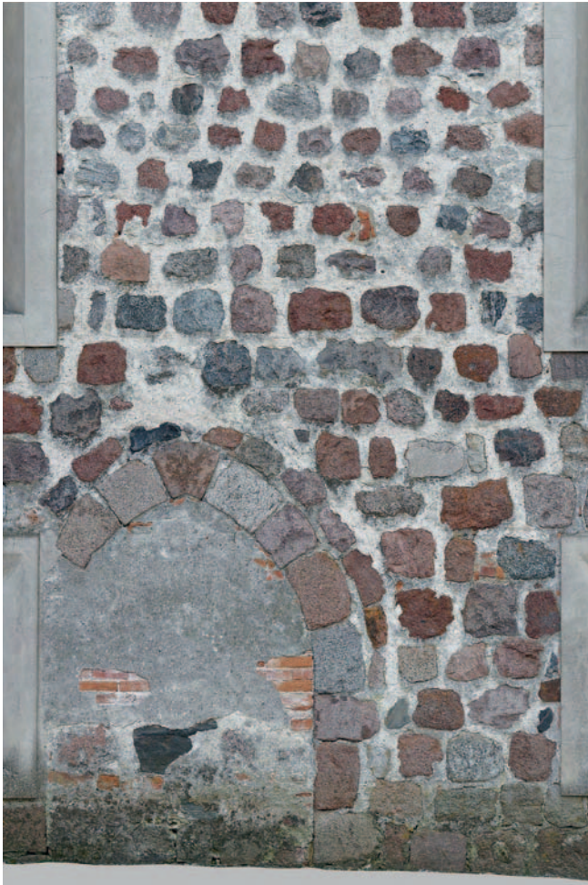
Abb. 36: Dorfkirche Briest, Messbildaufnahme des ausgewählten Referenzbereiches der Nordfassade, Messbildstelle GmbH, 2017
