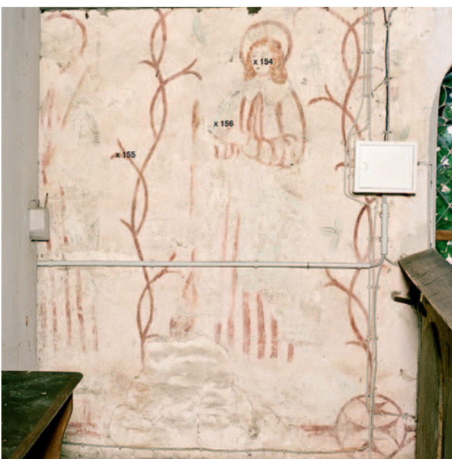
Abb. 14: Lübbenow, Feldsteinkirche, Nordwand, Apostel, Lokalisierung der Messpunkte bzw. der Probeentnahmestellen (RFA und REM/EDX)
