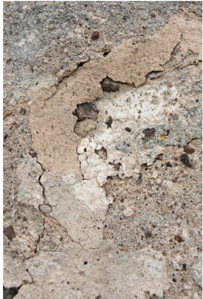
Abb. 37: Dorfkirche Kunow, Chor, Ostfassade, fortschreitende Verformung des Putzes nach der Konservierung im Jahre 2013, Foto Sonia Cárdenas, 2017
