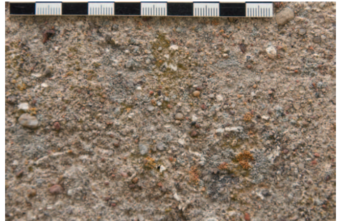
Abb. 15: Dorfkirche Kunow, Chor Ostfassade, Herauswittern der Zuschläge bei relativ abriebfester Oberfläche, Foto Sonia Cárdenas 2017
