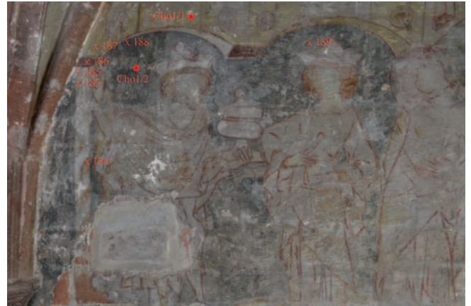
Abb. 12: Chorin, Zisterzienserkloster, Fürstensaal, Nordwand, Detail des in Abb. 13 gekennzeichneten Bereichs, Lokalisierung der Messpunkte bzw. der Probeentnahmestellen (RFA, REM/EDX, Raman)
