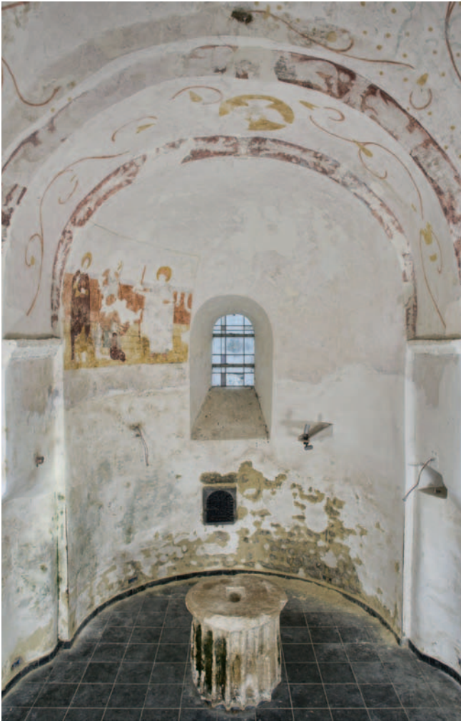
Abb. 2: Vieuxville, ehemalige Kirche Sankt-Peter-und-Paul, durch Feuchtigkeit und Salze gefährdete Wandmalereien des 16. Jh. (um 1520-1540), Zustand 2009 (© KIK-IRPA, Brüssel, X033035, 2009).
