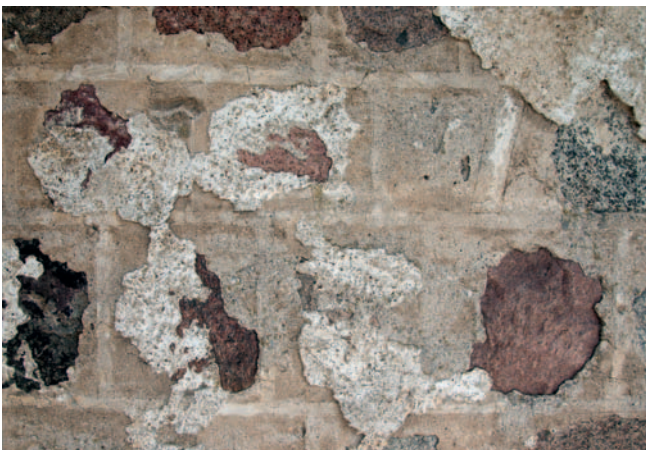
Abb. 2: Dorfkirche Kunow, Landkreis Uckermark, Chorsüdfassade mit mittelalterlicher Fugengestaltung, Foto Sonia Cárdenas, 2013
