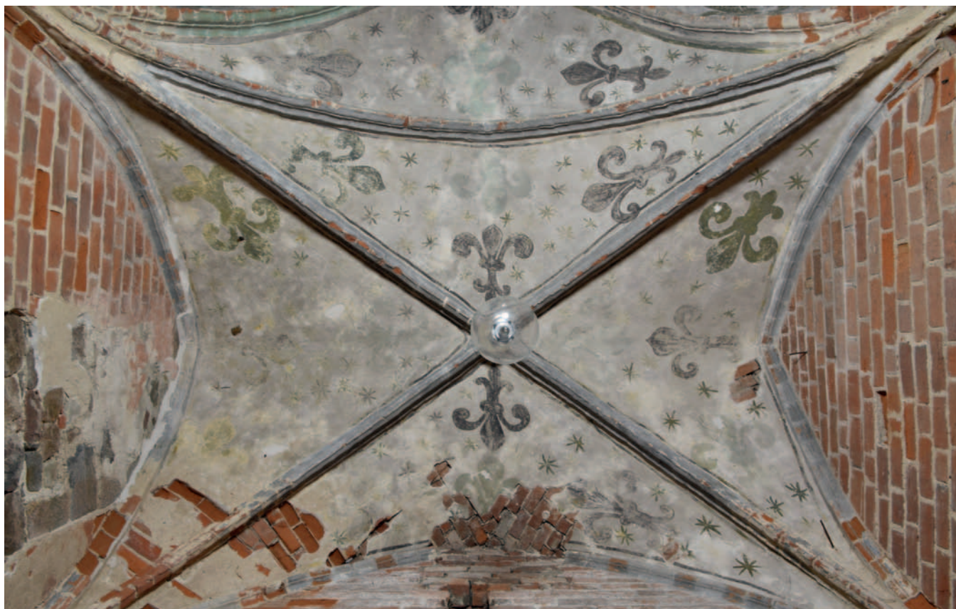
Abb 15: Angermünde Franziskanerklosterkirche, Sakristei, Joch IV von Osten. Die heutige Farbwirkung ist undifferenziert. Die ursprünglich blau erscheinenden Lilien wirken jetzt grau, graugrün bis bräunlich
