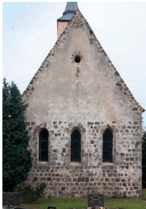
Abb. 12: Dorfkirche Kunow, Chor Ostfassade, Foto Sonia Cárdenas, 2016
