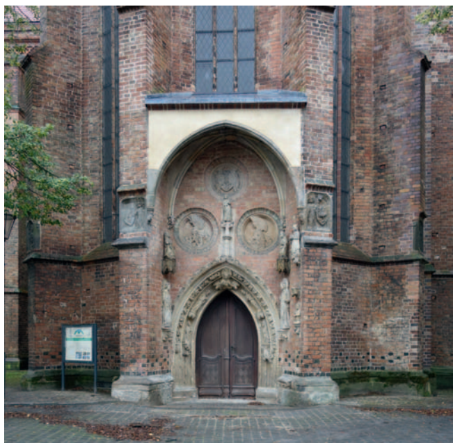
Abb. 8: Frankfurt (Oder), Marienkirche, Nordportal mit neuer Bleiabdeckung, Foto: Jan Raue 2016
