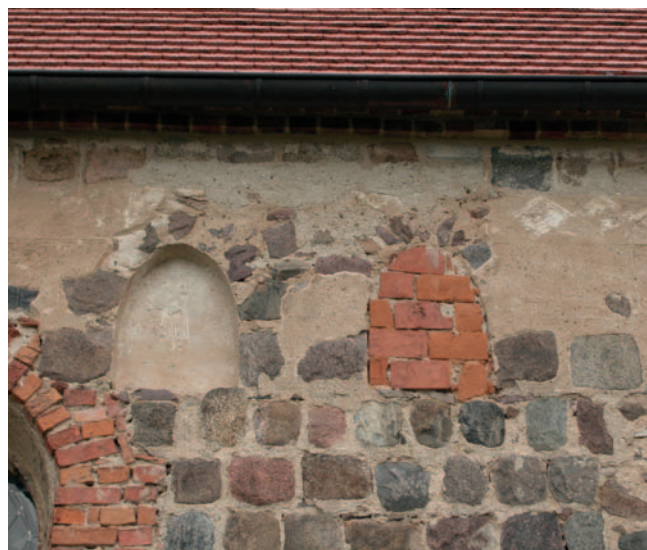
Abb. 3: Klaushagen, Friesgestaltung und Fugensystem des 13. Jh. auf der Nordfassade, Foto: Mechthild Noll-Minor, 2014
