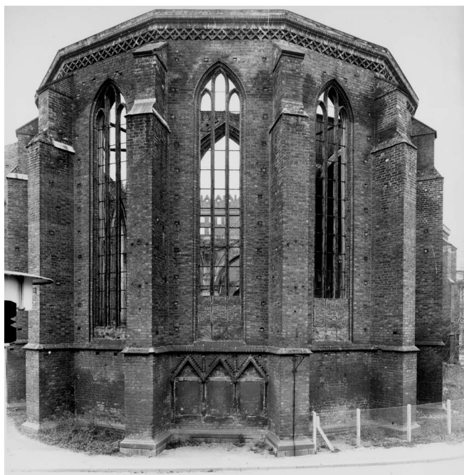
Abb. 13: Frankfurt (Oder), Marienkirche, Chor der Ruine der Marienkirche von Osten, Situation vor Abnahme der drei Epitaphen, welche jahrhundertlang die dreiteilige Außenwandmalerei abdeckten, Aufnahme: Hartmetz 1985
