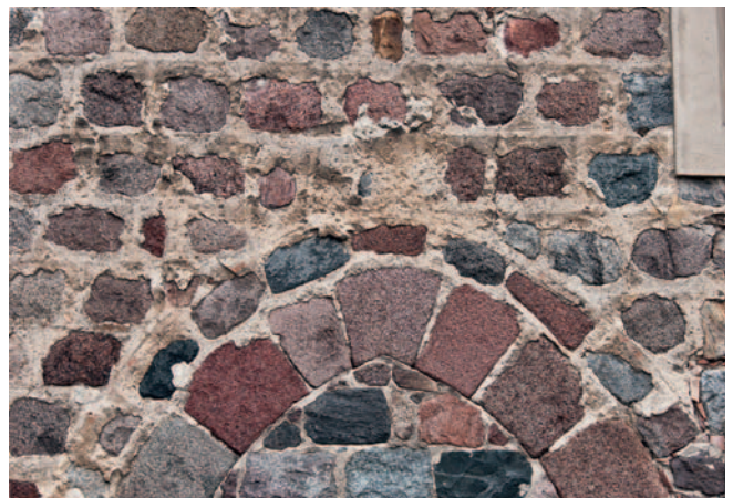
Abb. 3: Dorfkirche Briest, Landkreis Uckermark, Südportal mit mittelalterlicher Fugengestaltung, Foto Sonia Cárdenas, 2016
