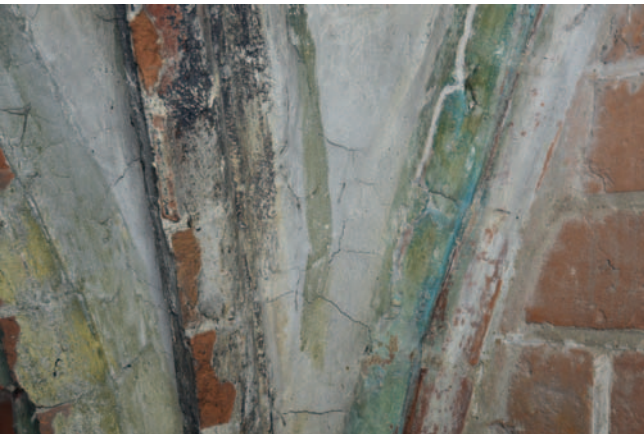
Abb. 20:: Angermünde, Sakristei, Gewölbe, Joch III, Übergang zur Südwand, Referenzfläche, Foto Ellen Egel, 2017
