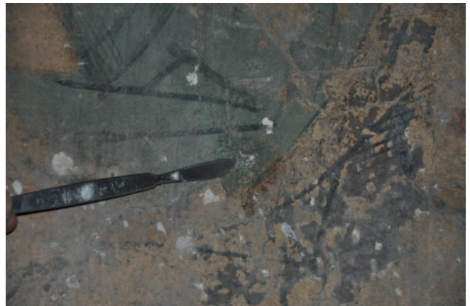
Abb. 12: Ang 1/2 – Vergrauetes Grün. Probenentnahmestelle
