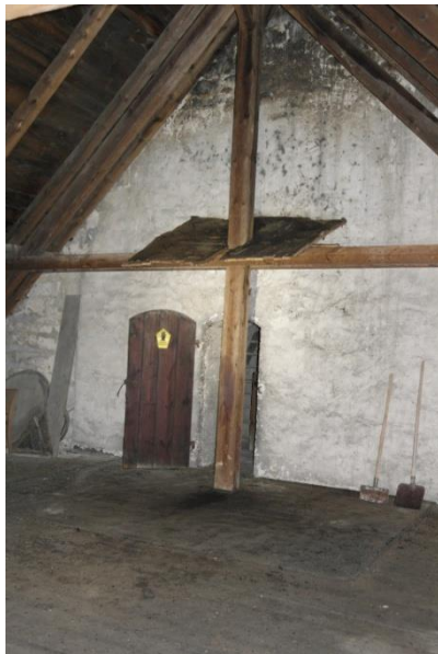
Abbildung 81. Abdachung über dem Eingang.
