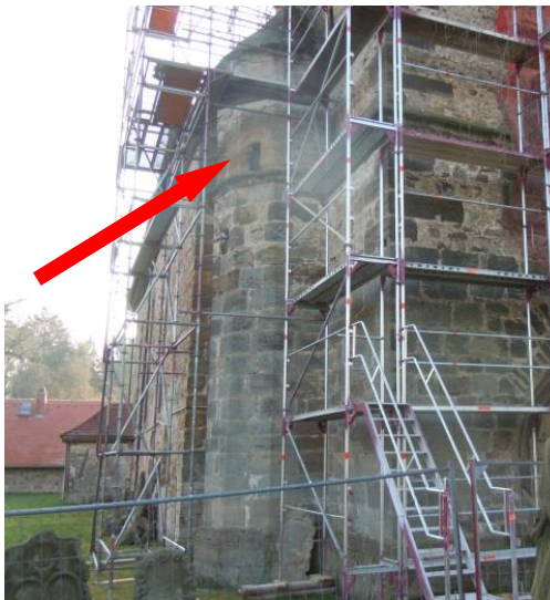
Abbildung 101. Einflug siehe Pfeil, Gerüst wurde großräumig um Öffnung freigehalten (keine Gerüststangen) und nicht mit Planen verkleidet, um Ein- und Ausflug nicht zu behindern. Der Zugang zur Baustelle im oberen Turmbereich erfolgte über einen Gerüsttreppenturm.
