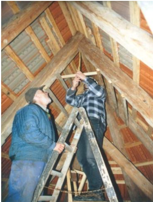
Abbildung 97. An die Innenseiten der Ziegel wurde Mörtel gespritzt, um diese für die Fledermäuse griffiger zu machen (im Bild grau).
