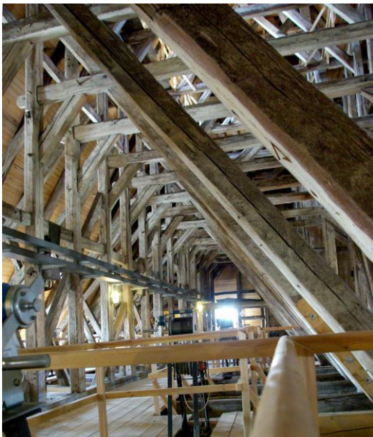
Abbildung 3. Ulrichskirche in Halle a.d. Saale, Dach über dem Hauptschiff: ein „verbauter Wald“.
