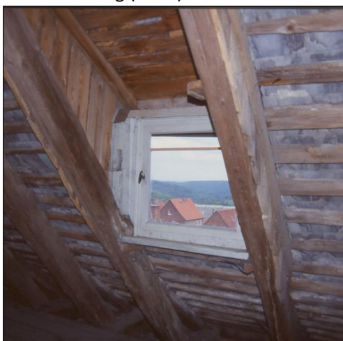
Abbildung 93. Dauerhaft gesicherte Einflugöffnung in Form eines geteilten Fensters. Im oberen Teil des Fensters wurde das Glas entfernt und mit einer Fensterleiste neu abgeschlossen.
