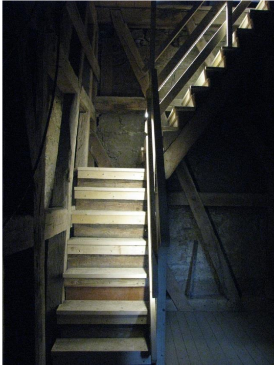
Abbildung 105. Das neue Treppenlicht im Turm wurde in der Etage mit dem Fledermaushangplatz speziell an die Schutzbedürfnisse angepasst.
