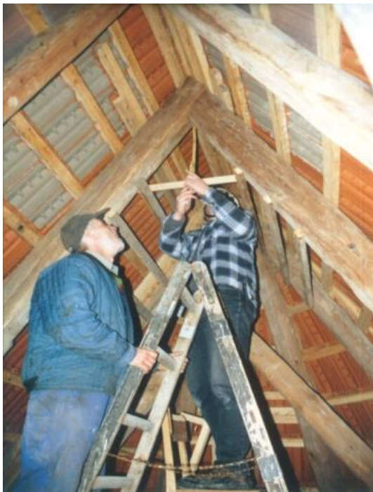
Abbildung 16. An die Innenseiten der Ziegel wurde Mörtel gespritzt, um diese für die Fledermäuse griffiger zu machen (im Bild grau). (Foto: FSU Jena)
