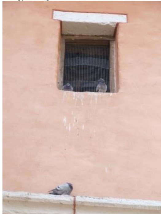
Abbildung 98. Das Aussperren von verwilderten Tauben und gleichzeitige Beibehalten von Ein- bzw. Ausflugsöffnungen für die Kleinen Hufeisennasen stellte eine der Herausforderungen dar, die für jedes Objekt eine individuelle Lösung erforderlich macht.
