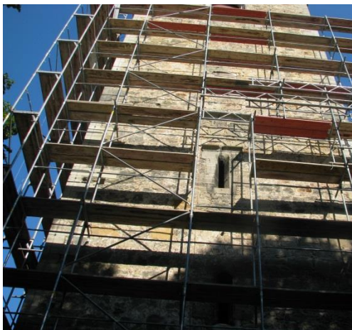
Abbildung 103. Das schmale Fenster dient den Fledermäusen als Aus- und Einflug. Das Gerüst wurde großräumig um die Öffnung freigehalten (keine Gerüststangen) und nicht mit Planen verkleidet.
