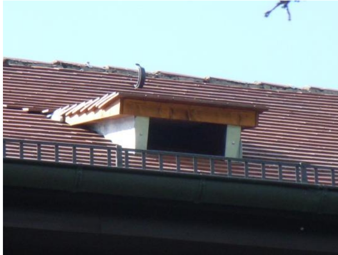
Abbildung 100. Einbau einer neuen Fledermausgaube im Bereich der NW-Seite des Daches über dem Kirchenschiff 2015 mit Anschluss zum Hangwald, in den die Kleinen Hufeisennasen fliegen.
