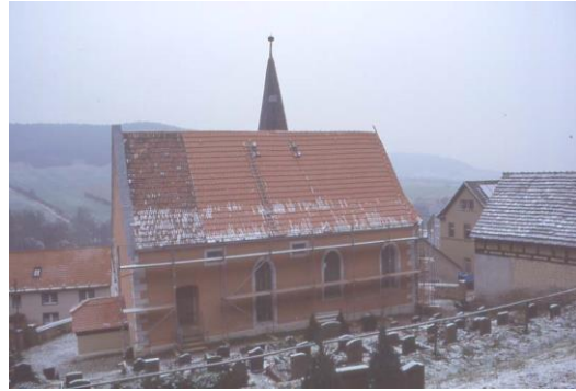
Abbildung 96. Im Winterhalbjahr 2001/02 wurde ein Viertel der Dachsüdseite (links) der Kirche von Altenberga noch im alten Zustand belassen und erst im Folgewinter neu gedeckt, um den Kleinen Hufeisennasen im Sommer 2002 einen vertrauten Rückzugsbereich mit unveränderten Hangplatzzeigenschaften zu belassen.
