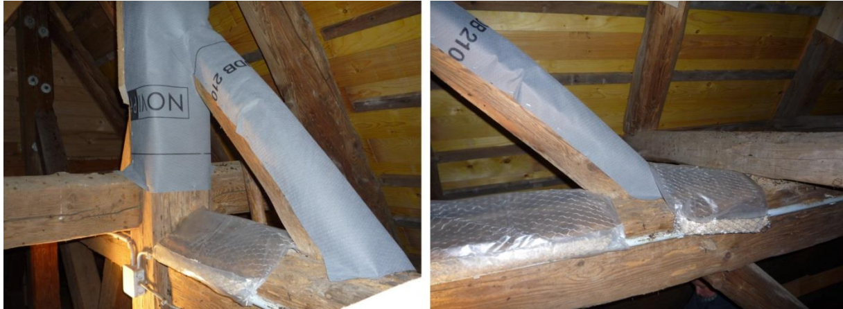
Abbildung 68. Abdeckung des schrägen Balkens und die Drahtkonstruktionen auf den senkrechten Balken mit seitlichen Rinnen für die Katzenstreu.
