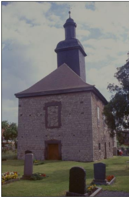
Abbildung 91. Kirche von Großkröbitz vor der Dachsanierung (2000).
