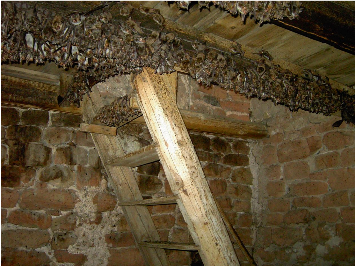
Abbildung 1. Große Mausohren in ihrem Quartier in Hundhaupten. Zu sehen sind außer den Tieren auch Kotkümel am (Leiter-) Holz sowie Verfärbungen an der Mauer sowie an den Holzbalken.
