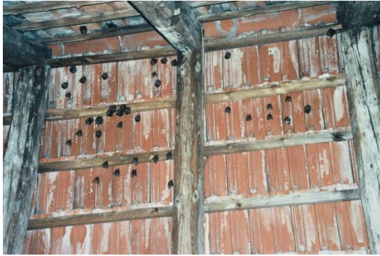
Abbildung 95. Blick in die Wochenstube vor der Dachsanierung. (Juli 1998).
