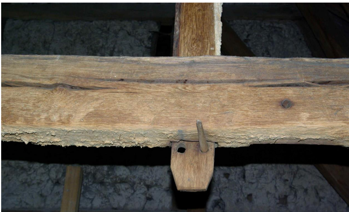
Abbildung 5. Meisenheim, Schlosskirche, durch Feuerschutzsalze geschädigtes Holz (Mazeration)
