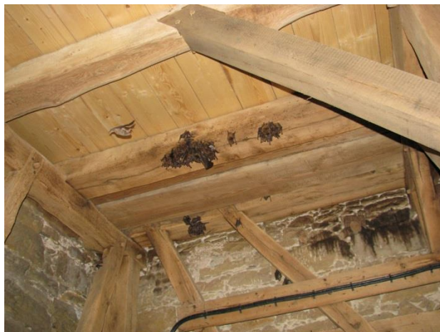
Abbildung 104. Hangplatz der Kolonie der Großen Mausohren im Kirchturm von Themar, eine Etage unter den Glocken.
