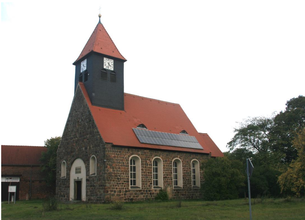
Abbildung 6. Blönsdorf, LK Teltow-Fläming, Brandenburg; Kirche in mit Solarmodulen: ein Einzelfall
