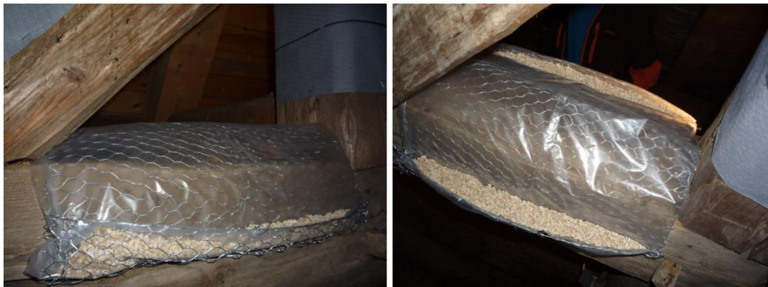
Abbildung 69. Drahtkonstruktionen auf den senkrechten Balken mit seitlichen Rinnen für die Katzenstreu (Detail).
