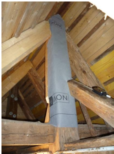
Abbildung 67. Stützbalken mit Folienverkleidung im Bereich des Hangplatzes und Klimadatenlogger auf dem schrägen Dachbalken, der danach noch verkleidet worden ist.
