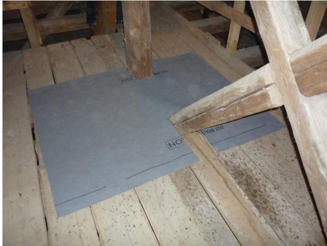
Abbildung 70. Abdeckung des Bodens unter dem Hangplatz mit der diffusionsoffenen Unterspannbahn.
