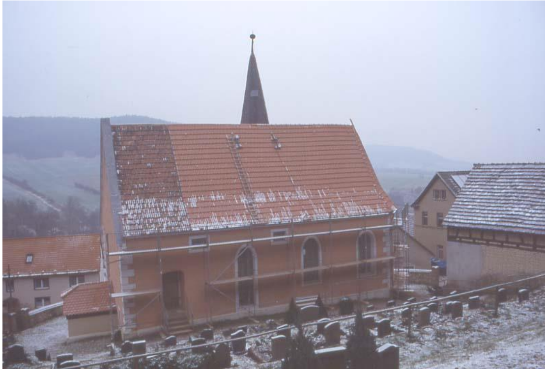
Abbildung 15. Im Winterhalbjahr 2001/02 wurde ein Viertel der Dachsüdseite (links) der Kirche von Altenberga noch im alten Zustand belassen und erst im Folgewinter neu gedeckt, um den Kleinen Hufeisennasen im Sommer 2002 einen vertrauten Rückzugsbereich mit unveränderten Hangplatzeigenschaften zu belassen. (Foto: I. Karst)
