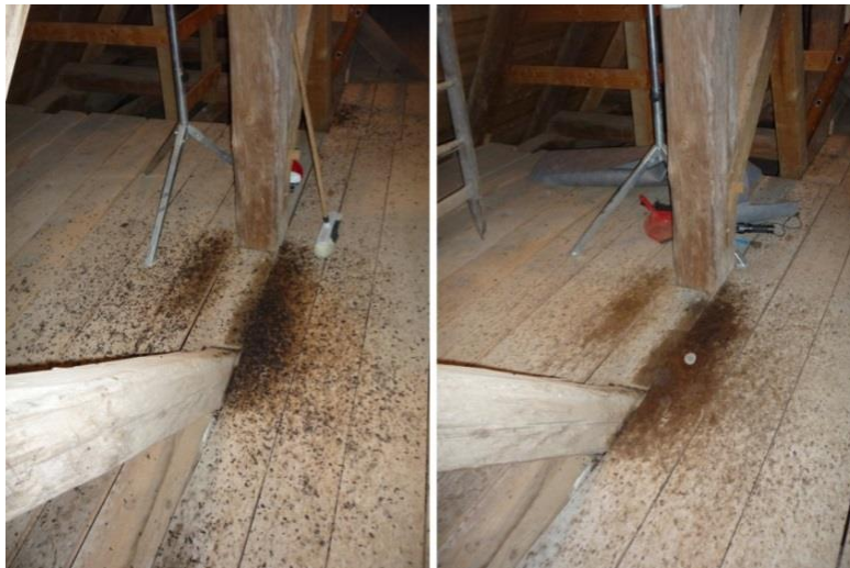
Abbildung 66. Boden unterhalb des Hangplatzes mit Kotauflage und nach dessen Entfernung.
