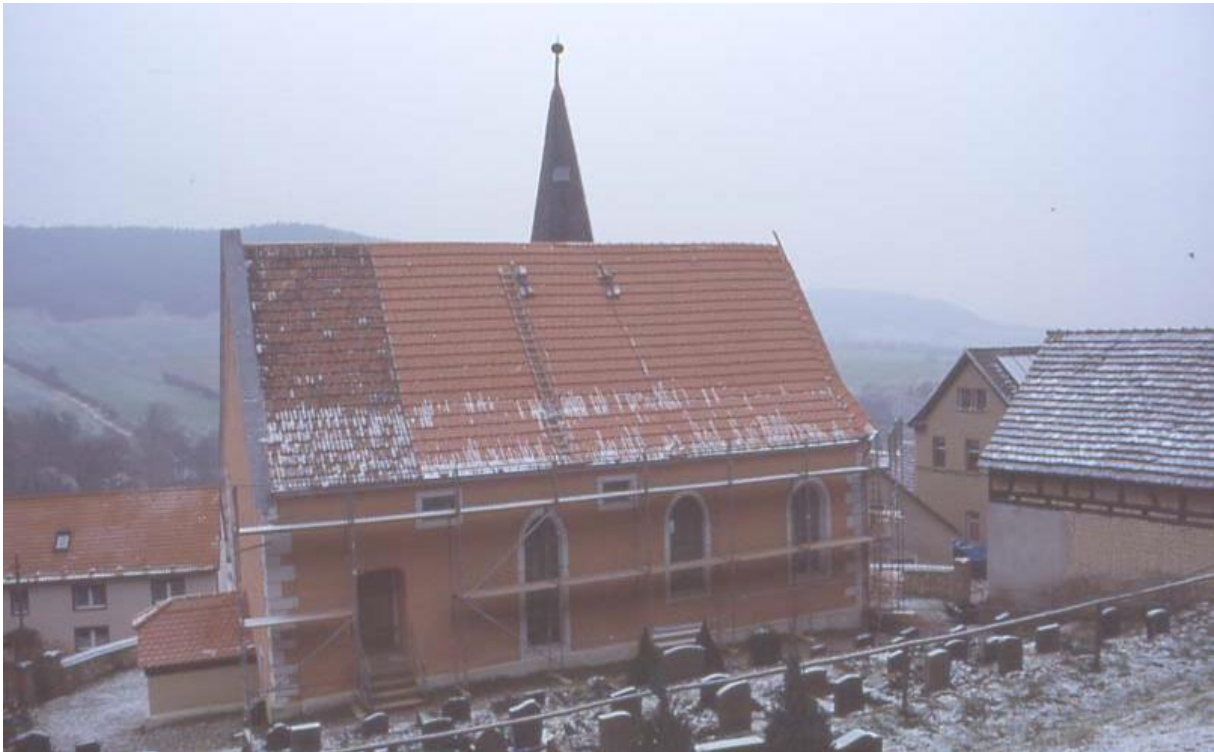
Abbildung 15. Im Winterhalbjahr 2001/02 wurde ein Viertel der Dachsüdseite (links) der Kirche von Altenberga noch im alten Zustand belassen und erst im Folgewinter neu gedeckt, um den Kleinen Hufeisennasen im Sommer 2002 einen vertrauten Rückzugsbereich mit unveränderten Hangplatzeigenschaften zu belassen. (Foto: I. Karst)
