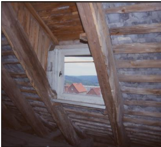
Abbildung 13. Dauerhaft gesicherte Einflugsöffnung in Form eines geteilten Fensters). Im oberen Fünftel des Fensters wurde das Glas entfernt und mit einer Fensterleiste neu abgeschlossen. Foto: (I. Karst)
