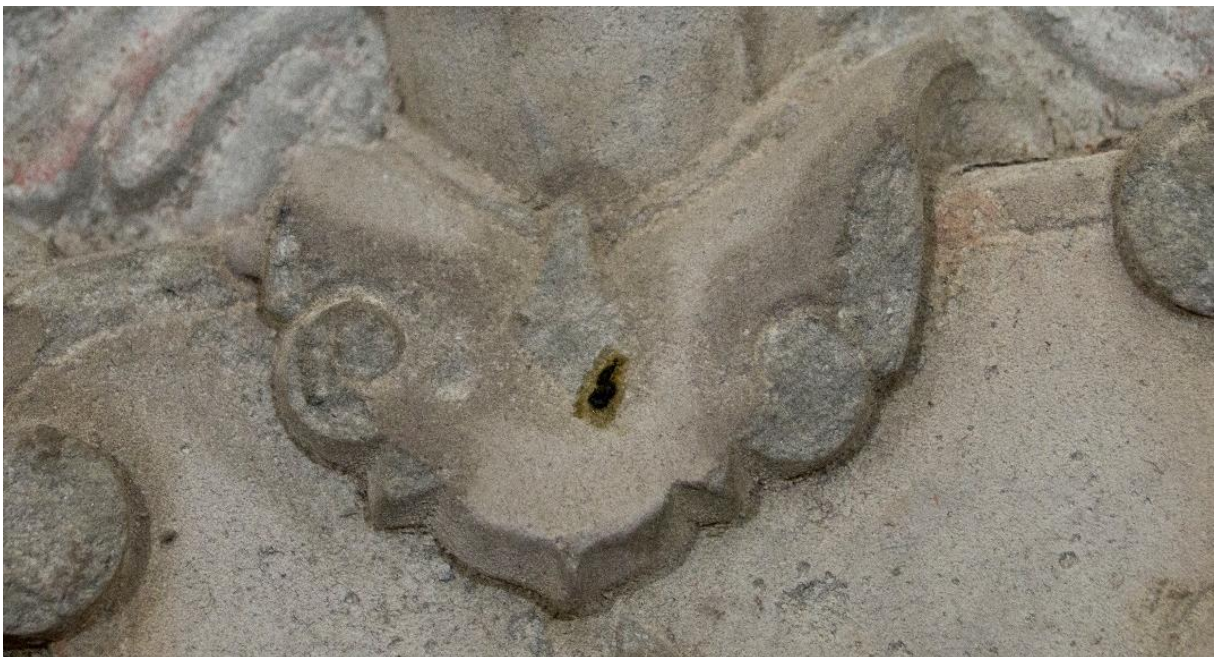
Abbildung 5. Kotauflage auf einer Skulptur (Detail). Gut zu erkennen ist der durch in den Stein eingedrungene Feuchtigkeit erzeugte „Hof“. (Foto: B. Hübner)
