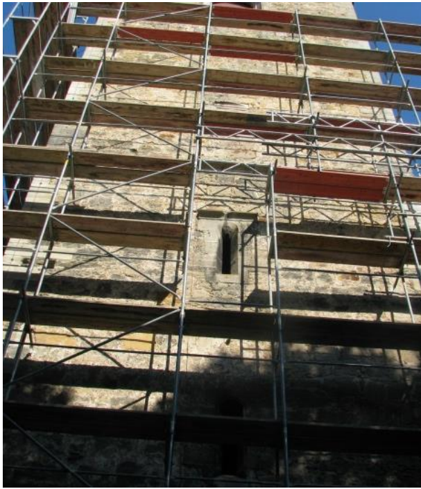
Abbildung 23. Das schmale Fenster dient den Fledermäusen als Aus- und Einflug. Das Gerüst wurde großräumig um die Öffnung und nicht mit Planen verkleidet. (Foto: W. Schorcht)
