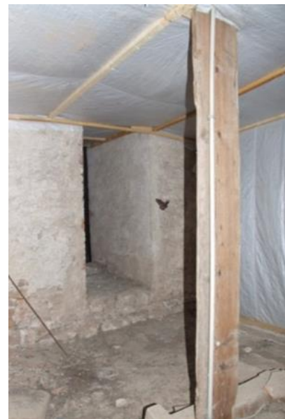
Abbildung 21. Im Zuge der Turmsanierung vorsorglich abgetrennter Flugraum im Eingangsbereich des Dachraums über dem Kirchenschiff mit den Haupthangplätzen. Der Aufstieg in die oberen Turmbereiche (rechts im Bild) wurde mit Folie abgetrennt um Störungen fernzuhalten. (Foto: M. Biedermann)
