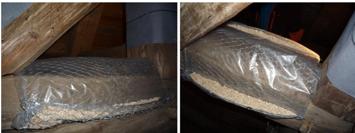
Abbildung 11. Drahtkonstruktionen auf den senkrechten Balken mit seitlichen Rinnen für die Katzenstreu (Detail). Es empfiehlt sich, diese Rinnen etwas größer auszuführen als im Bild zu sehen. (Fotos: J. Meinhardt)
