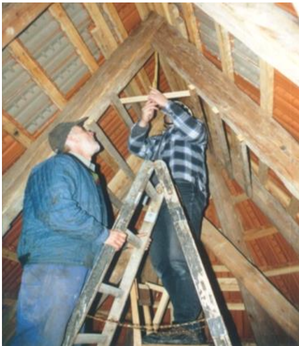
Abbildung 16. An die Innenseiten der Ziegel wurde Mörtel gespritzt, um diese für die Fledermäuse griffiger zu machen (im Bild grau). (Foto: FSU Jena)
