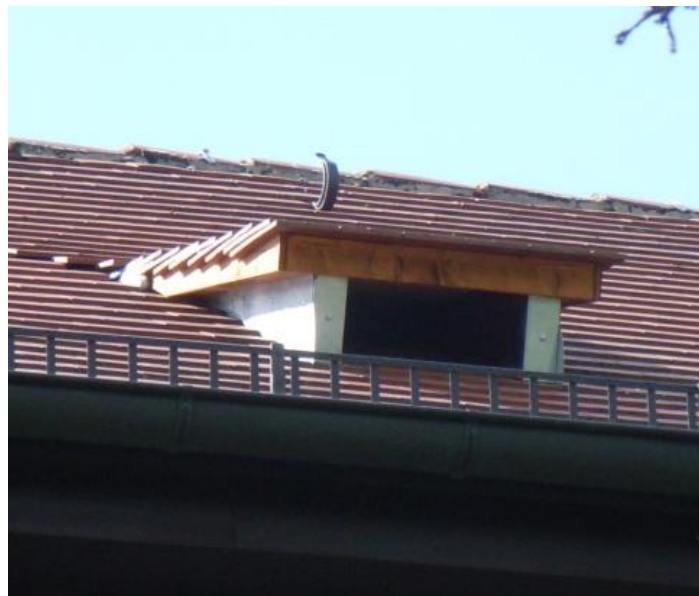
Abbildung 19. Einbau einer neuen Fledermausgaube im Bereich der NW-Seite des Daches über dem Kirchenschiff 2015 mit Anschluss zum Hangwald, in den die Kleinen Hufeisennasen fliegen. (Foto: M. Biedermann)
