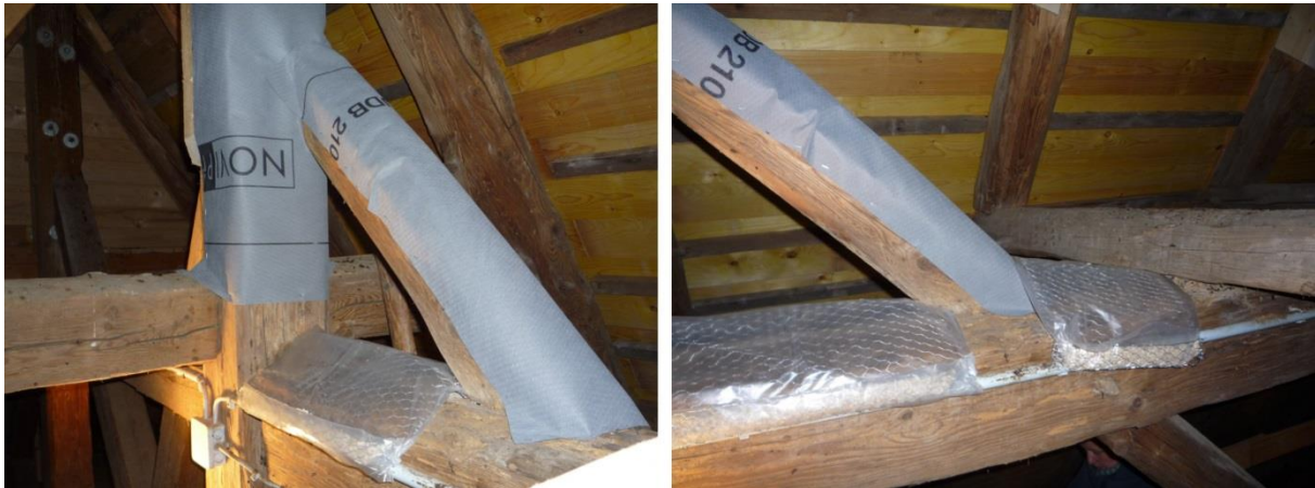
Abbildung 10. Abdeckung des schrägen Balkens und die Drahtkonstruktionen auf den senkrechten Balken mit seitlichen Rinnen für die Katzenstreu. (Fotos: J. Meinhardt)
