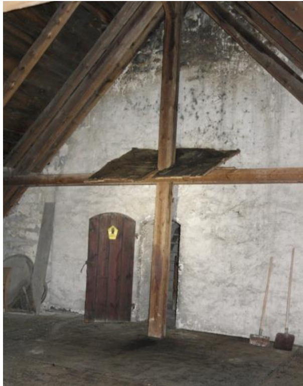
Abbildung 7. Blick in einen von Fledermäusen genutzten Dachraum: an der Zugangstür das gelbe Schild mit dem Hinweis auf das Quartier, über der Tür und unter einem der Hangplätze Bretter als Kotschutz, rechts Schaufeln, die zur Kotberäumung dienen. (Foto: J. Meinhardt)
