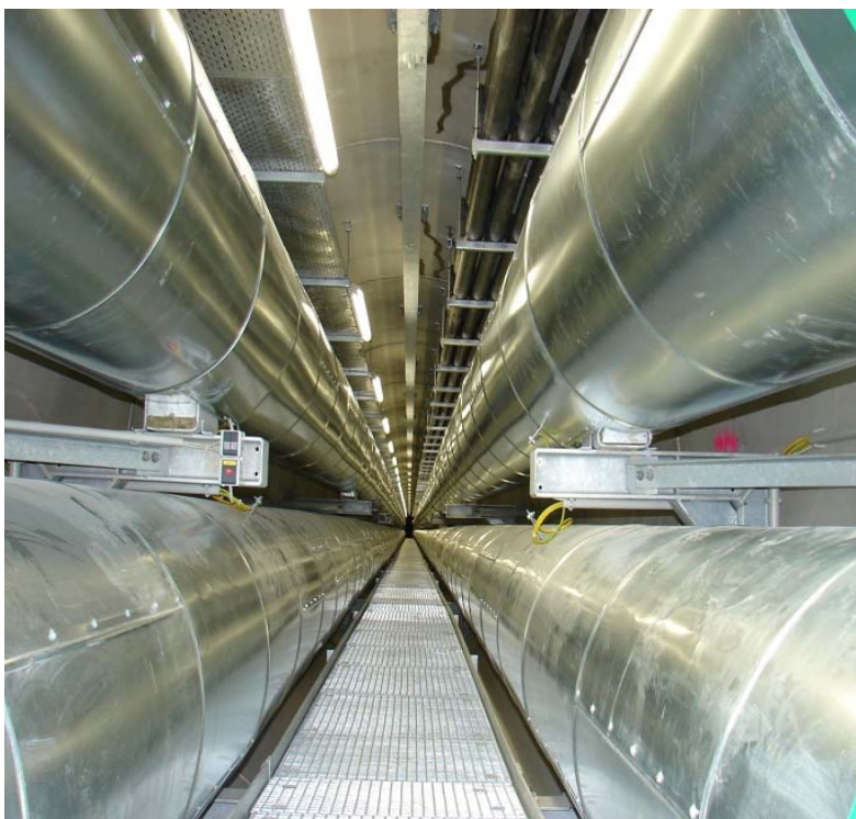
Bild B35: Versorgungskanal in geschlossener Bauweise nach Inbetriebnahme
