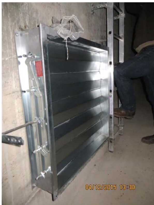
Bild B26: Zuluft – Regelklappe zum Einsatz in Versorgungskanälen
