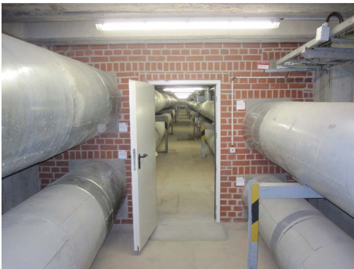
Bild B21: Nachrüstung einer Brandwand im Bestandskanal
