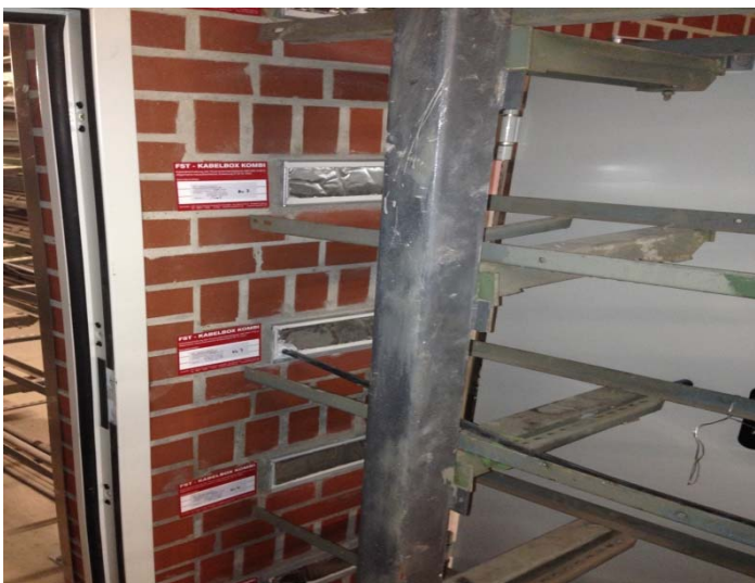
Bild B22: Montage von Kabelboxen zur Nachrüstung von Kabeln
