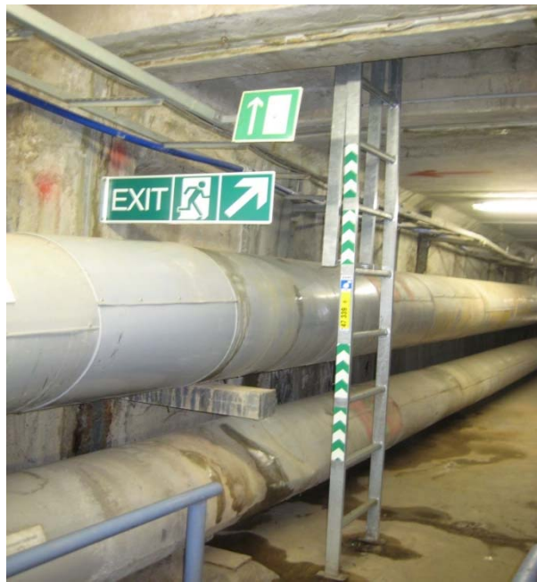
Bild B30: Vergleich Alt- und Neubeschilderung sowie der Leiterkennzeichnung mit unterschiedlicher Leuchtstärke
