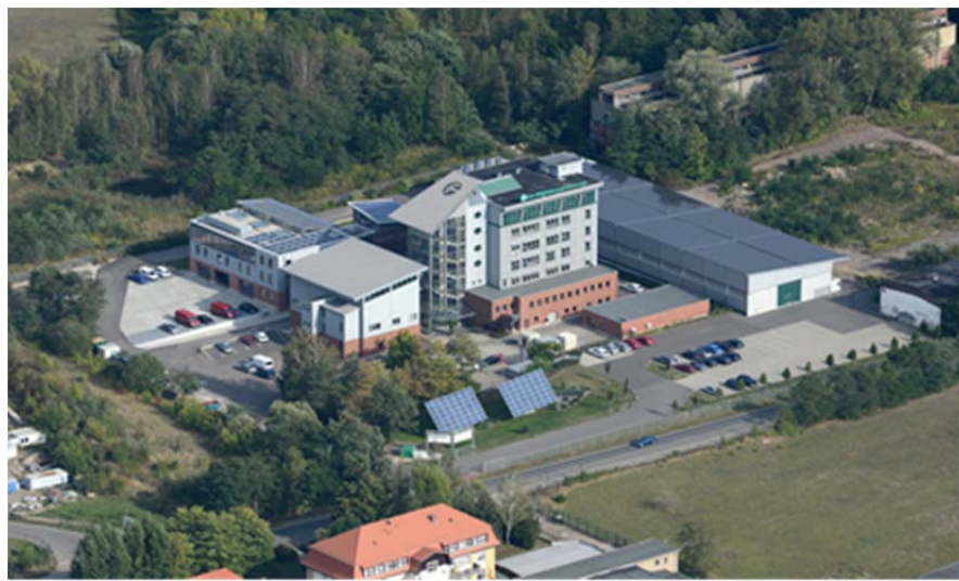
Bild B1: Standort der Dr. Födisch Umweltmesstechnik AG
