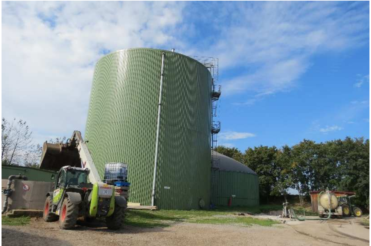
Abbildung 2.3: Anlage 3: Fermenter aus Stahl mit Massivdecke und Nachgärer aus Beton mit Tragluftdach
