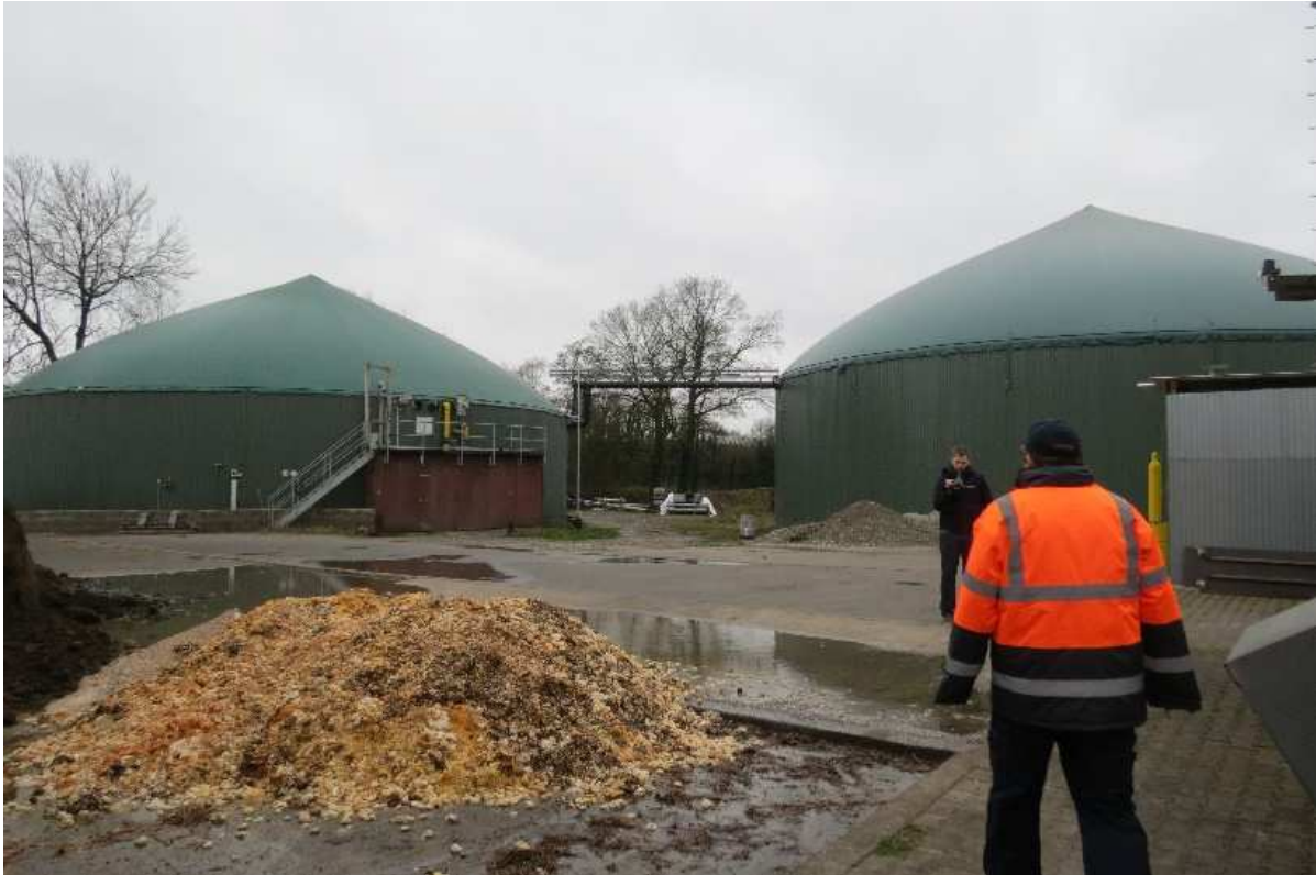
Abbildung 2.4: Anlage 4: Fermenter und Nachgärer aus Beton mit Tragluftdächern
