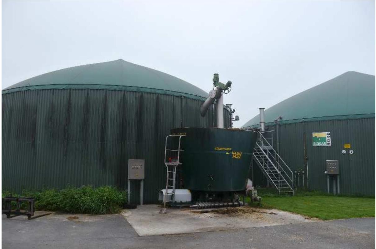
Abbildung 2.2: Anlage 2: Fermenter und Nachgärer mit Tragluftdächern
