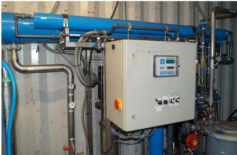
Abbildung 2.5: Aufnahme der Umkehrosmoseeinheit (RO II/III) im Filtrationscontainer
