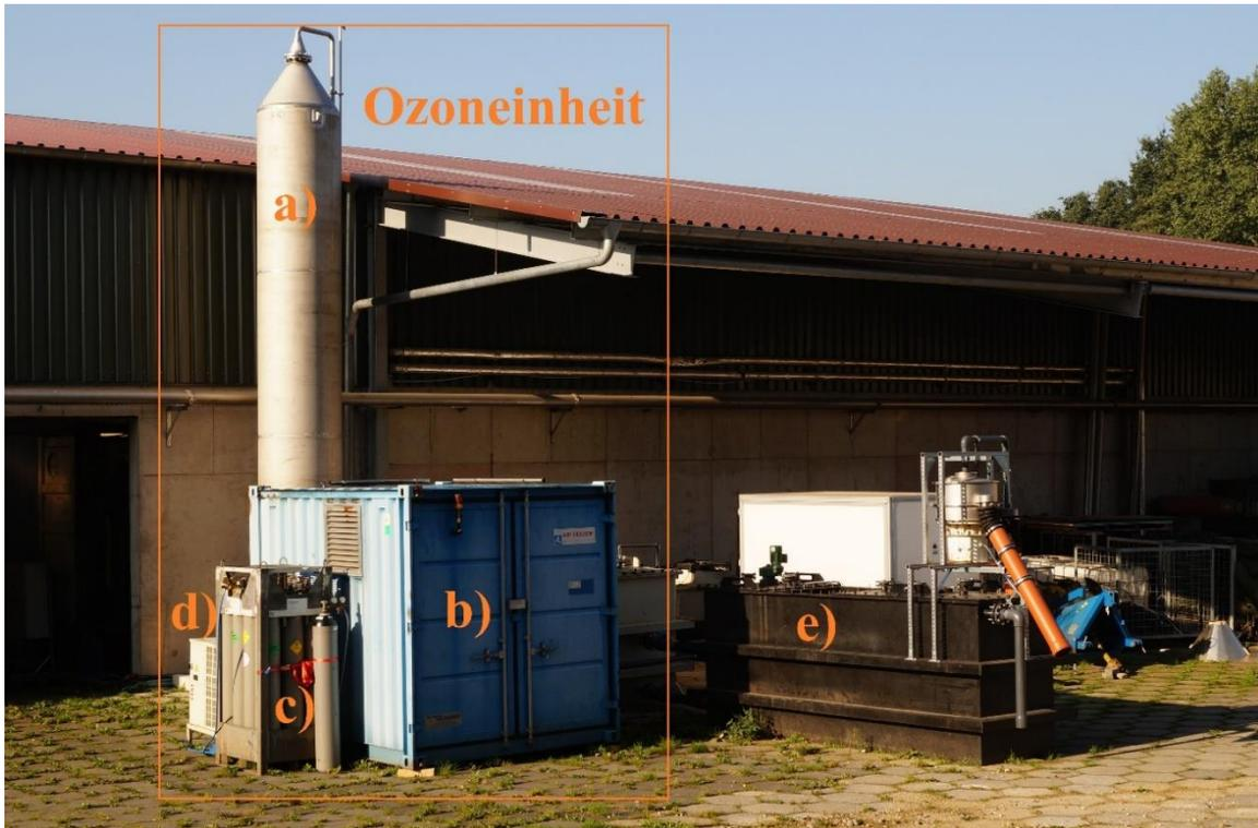
Abbildung 2.8: Aufbau Ozonierung Pilot-Maßstab a) Ozonreaktor (5 m<sup>3</sup>) b) Ozoncontainer mit Generator, c) Sauerstoff- und Stickstoffbündel, d) Kühlgerät, e) Vorlagetank (5m<sup>3</sup>)
