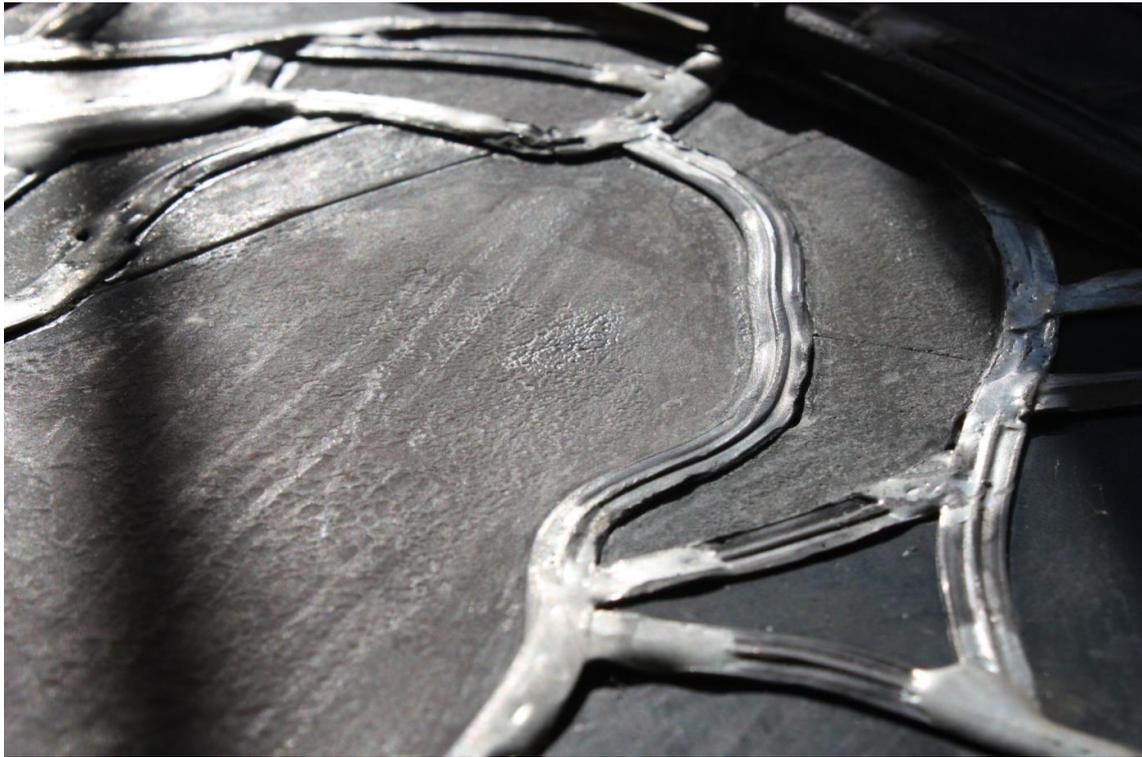
Bild 30: PM3: Feld nIX 6b; Außenseite, glänzende Beschichtung, Probenahme mit Skalpell
