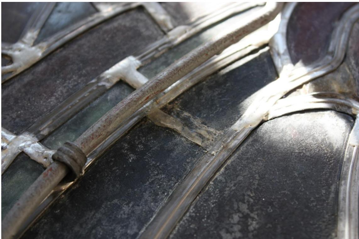
Bild 31: PM4: Feld nIX 6b; Außenseite, Klebung/Beschichtungsmaterial abstehend
