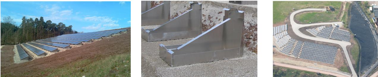
**Abbildung 2: Terrassenförmige Anordnung von PV- Modulen und einer Deponie mit seitlicher Folieneindeckung**
