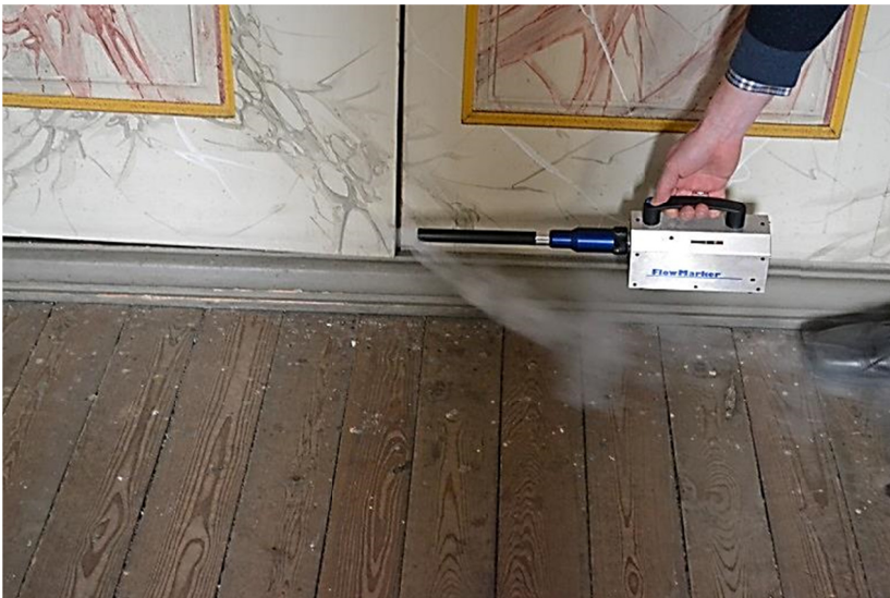
Abb. 57 Luftaustritt aus dem Orgelgehäuse im Bereich eines Türspaltes
