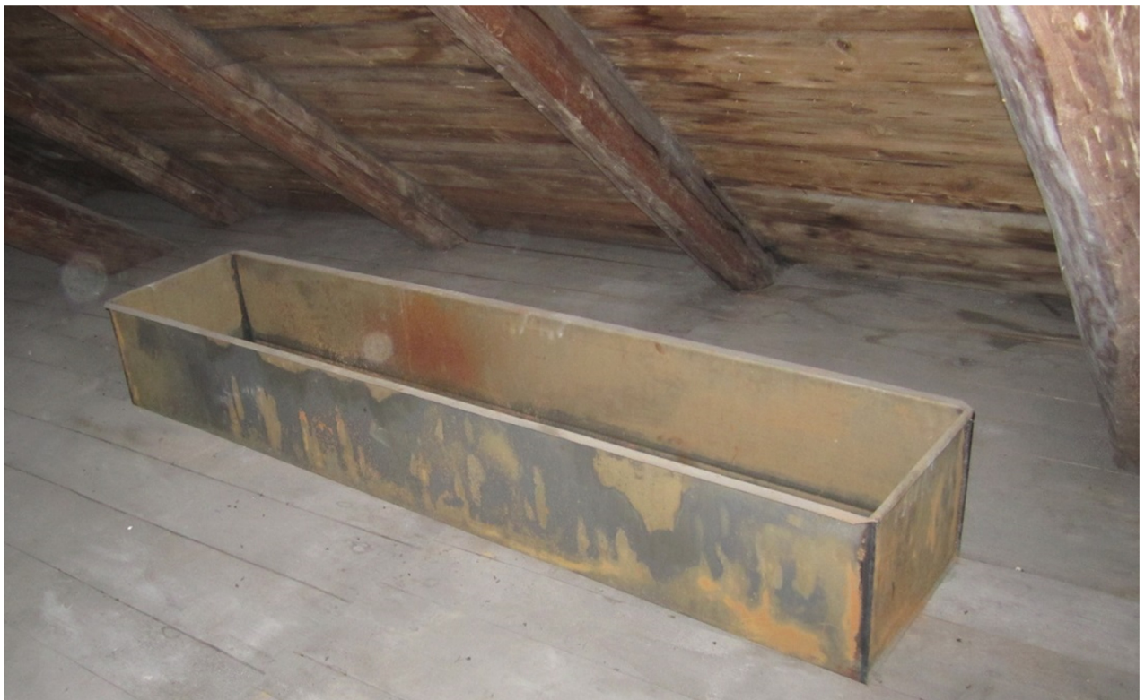
Abb. 66 Mutmaßlich zur Holzschutzmitteltränkung von langen Holzteilen (Orgelpfeifen?) benutzte Wanne (Thum-Herold, Kirche)
