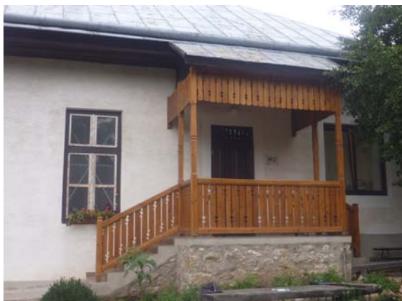
Eingangsbereich mit neuer Brüstung
