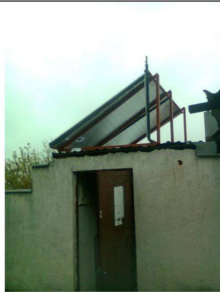
Abb. 11 Installierte Solarkollektoren auf dem Dach der Berufsschule in Zagreb
