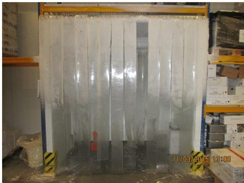
Abbildung 18: Lamellenvorhang im Tiefkühlager
