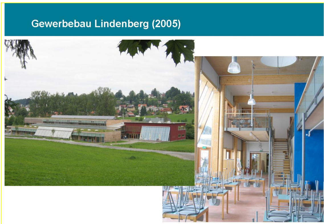
Abb. 7-5 Lebenshilfe Lindenberg Ansicht, Innenraum Kantine
