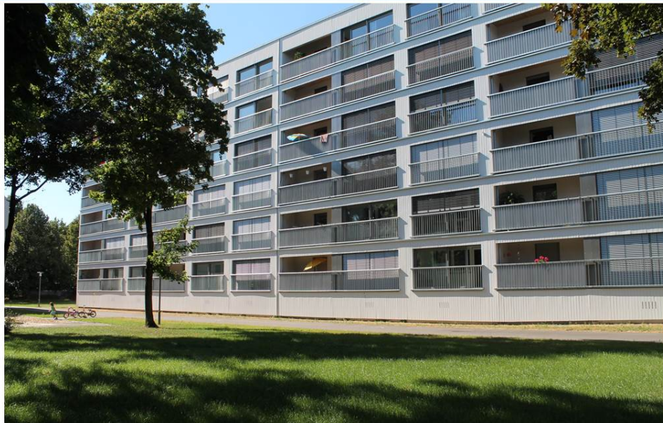
Abb. 9-5: Wohnungsbau Augsburg Modernisierung Ansicht
