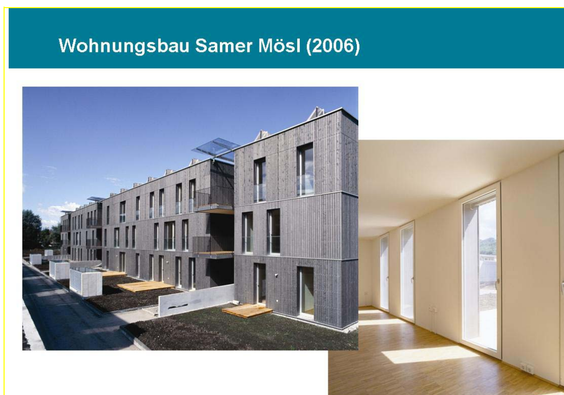
Abb. 7-11: Wohnungsbau Samer Mösl, Ansicht, Innenraum
