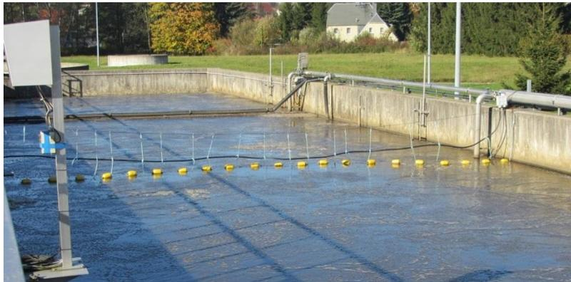
Abbildung 5.43: Fangnetz mit gelben Schwimmern und Sendespule am Überlauf zwischen 4. und 5. Kaskade an der KA-Ebersbach (SOWAG).
