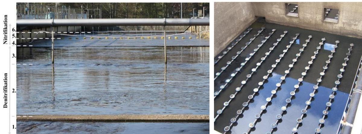
Abbildung 5.35: (Links) Ansicht der rechten Strasse der KA-Ebersbach in Fließrichtung. (Rechts) Kaskade zur Nitrifikation mit den Tellerbegasern.
