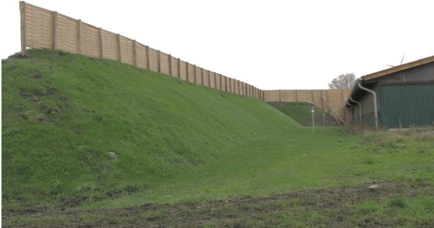
Abbildung 4.5: Blick auf den Damm von Norden
