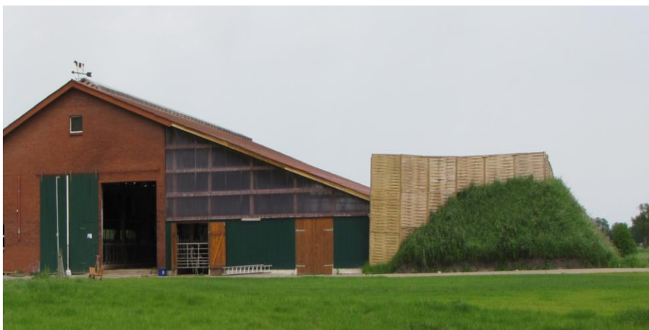
Abbildung 4.6: Blick auf den Damm von Süden
