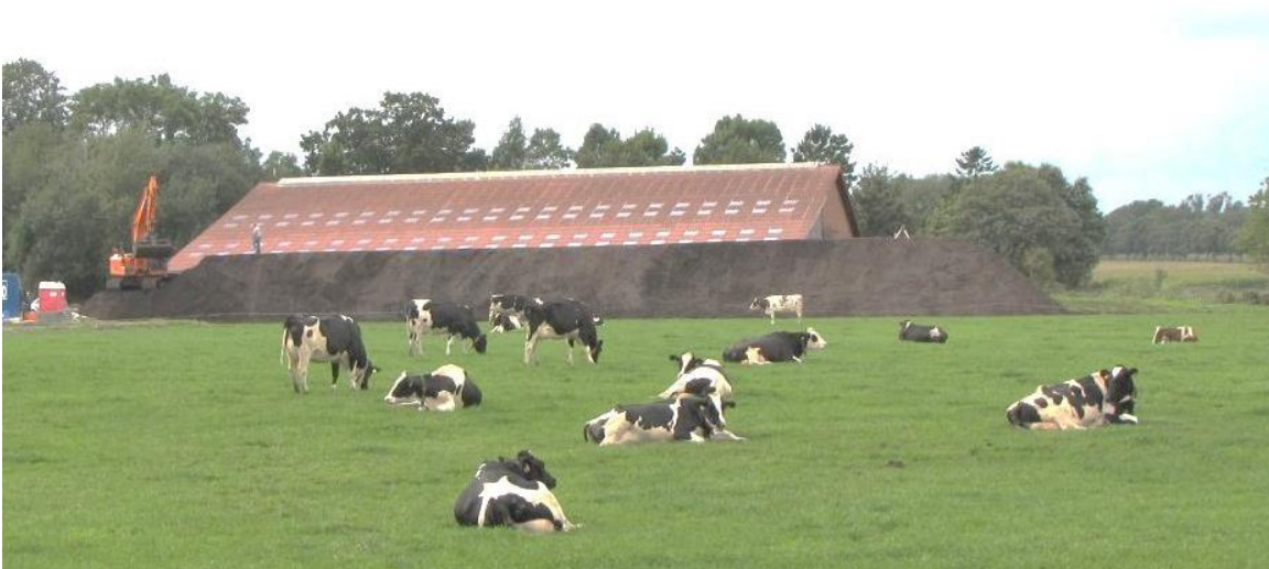
Abbildung 4.4: Immissionsschutzwall in der Bauphase (Blick von Westen)
