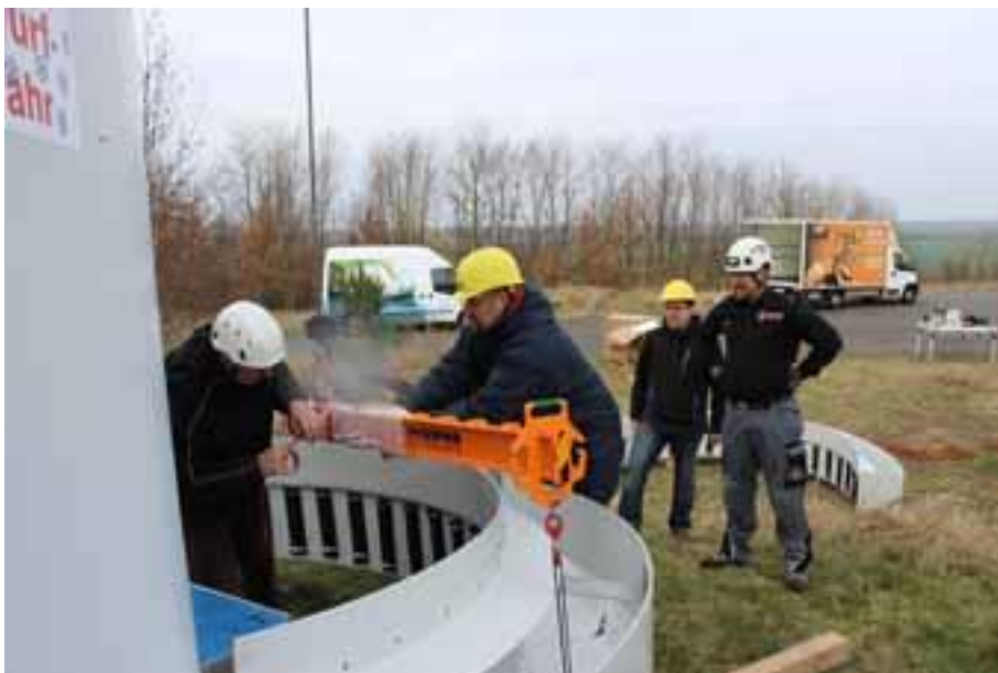
Bild 33: Befestigung der Traverse
