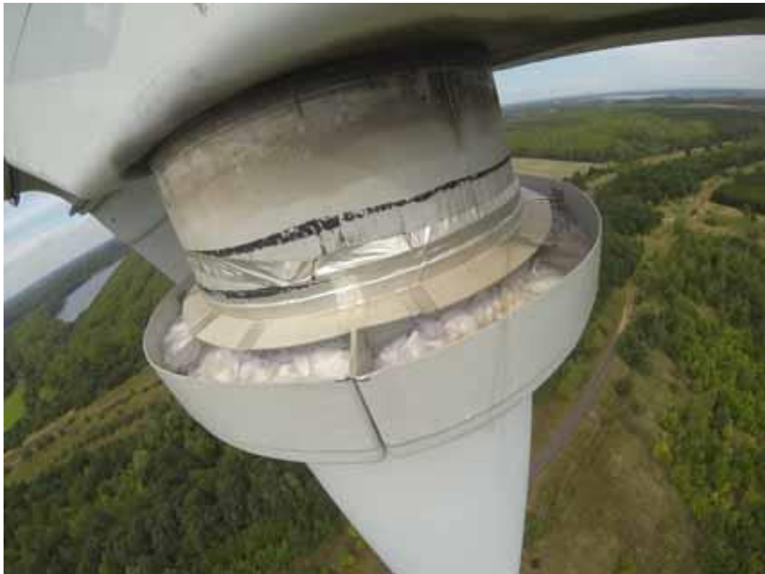
Bild 45+46: Farb-Veränderung des Bindemittels durch UV-Strahlung nach sechs Monaten
