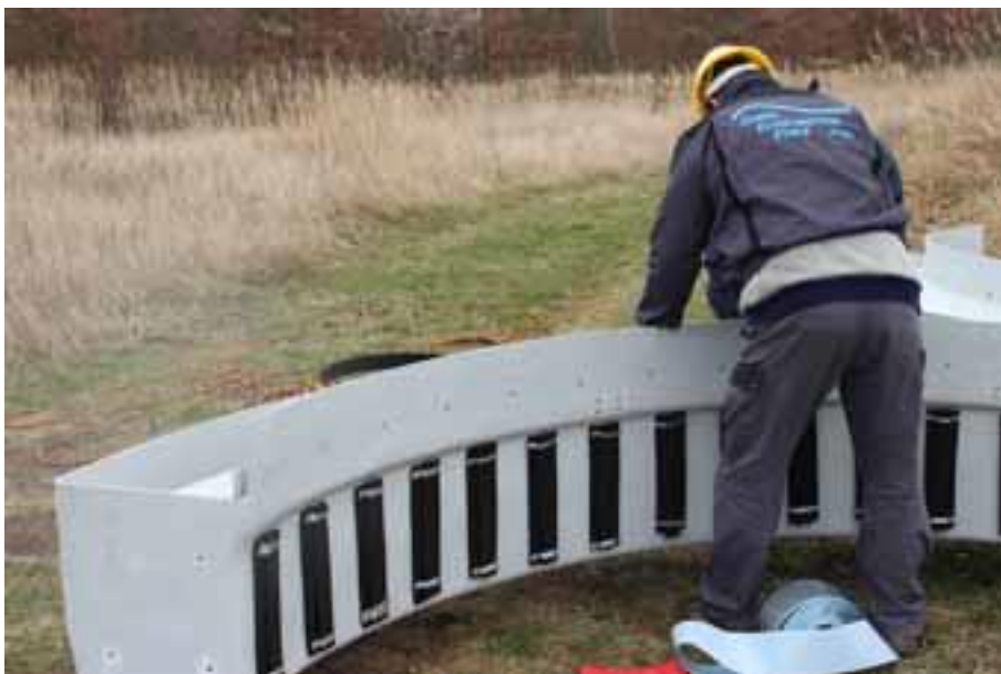
Bild 31. Befestigung der Moosgummistreifen als Rutschhemmung
