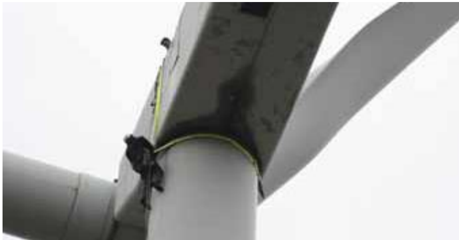
Bild 32: Montagehilfe Schwerlastgurt
