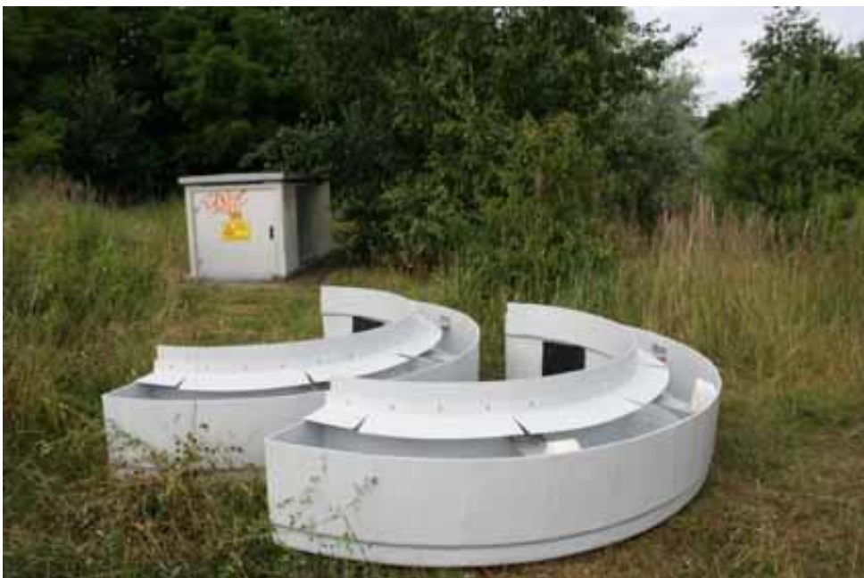
Bild 35: Die Halbschalen des zweiten OSC vor der Montage
