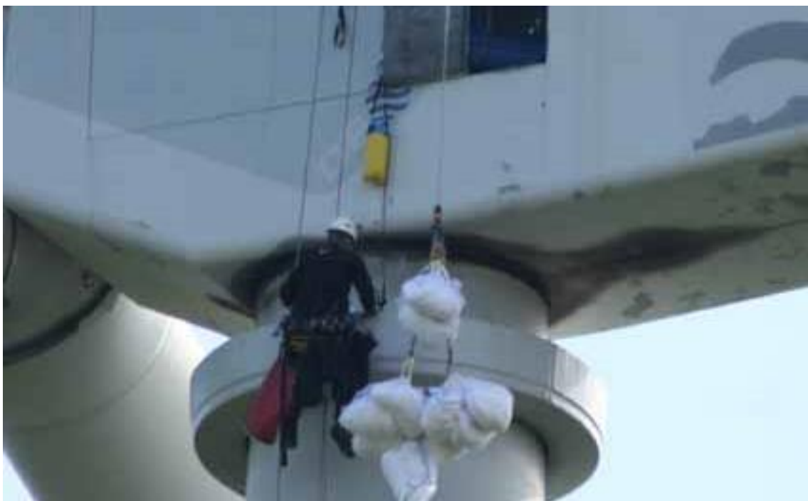
Bild 42: Einlegen der Bindemittelpackungen
