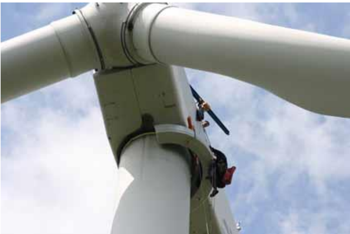
Bild 39 + 40: Vormontage der ersten Halbschale
