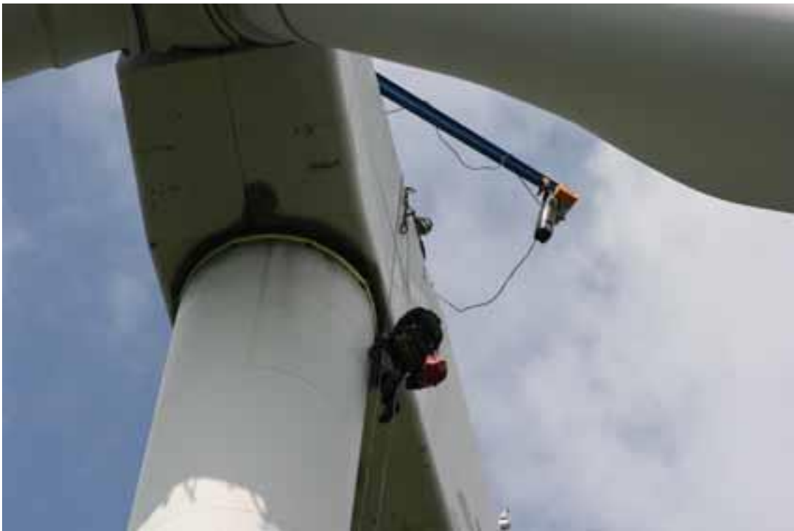
Bild 38: Vormontage des Schwerlastgurts
