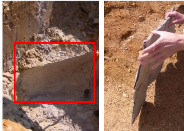
Abbildung 6-4: Freigelegter Injektionskörper der ersten Versuchsreihe
