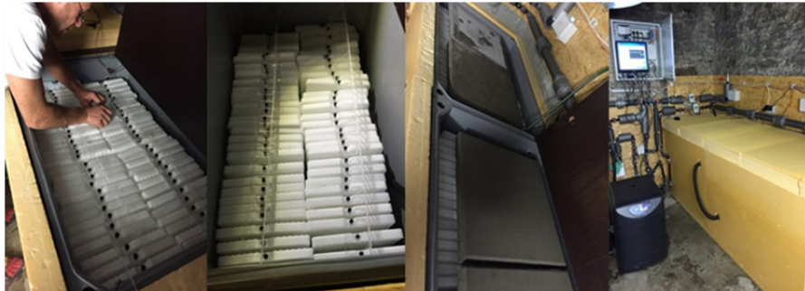
Bild 3 Einbau der PCM-Behälter
