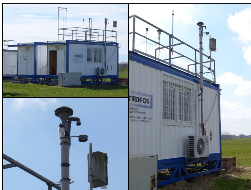
Abb. 3.11-2: Messcontainer mit seitlichem \text{PM}_{10} -Gaseinlass.
