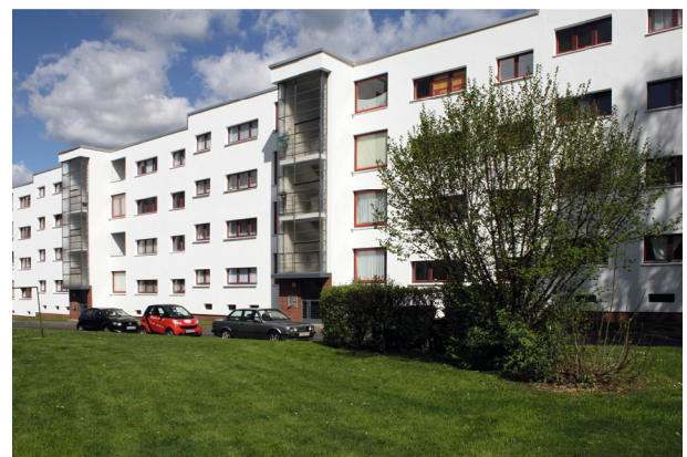
Abb. 8: Rothenberg-Siedlung in Kassel (Foto: ISP 2013)
