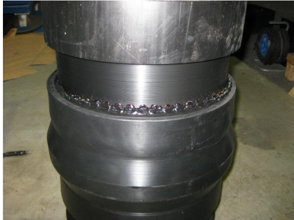
Abbildung 3-31: Aus der Schweißnaht ausgetretener Heizdraht (Muffe D315)
