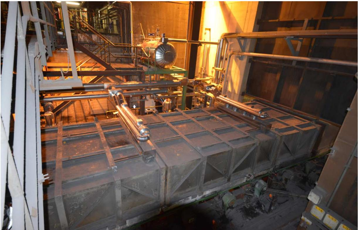
Bild 1: Anlage mit Dampftrommel, Verrohrung und Wärmetauschern
