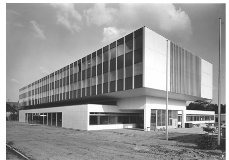
Abb. 3 Ansicht Nord-West, bauzeitliche Aufnahme Foto: Akademie der Künste AdK77-3-4_7a
