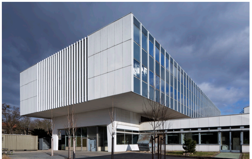
Abb. 7 Ansicht Süd-West Foto: TU Dresden Institut für Baukonstruktion; Fotograf: Werner Huthmacher
