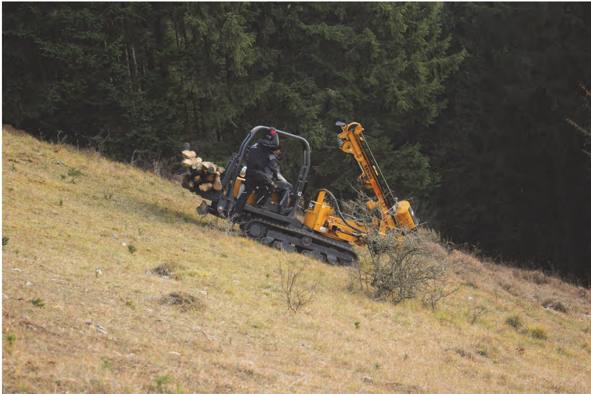
Abb. 12: Hydraulische Pfahlramme setzt Zaunpfosten am Wulsenberg (Biologische Station HSK, 2016)
