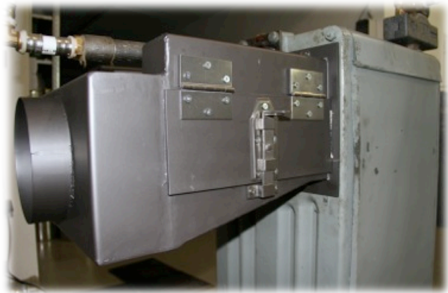
ABBILDUNG 17: CHIMCAT™ RETRO GK AN GK21 KESSEL
