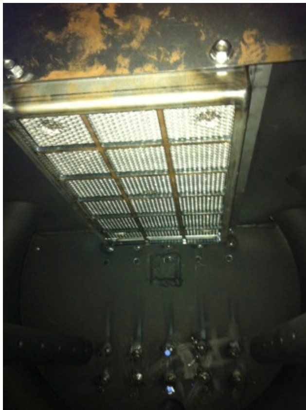
ABBILDUNG 11: KATALYSATORMODULL DER BULLERJANÖFEN
