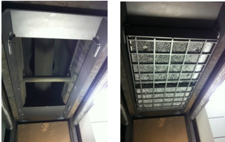
ABBILDUNG 9: EINBAUSITUATION OBERHALB DER BRENNKAMMER
