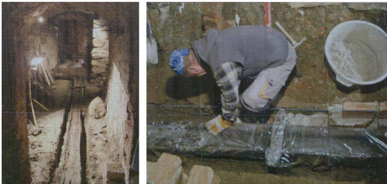
*Bild 312. Hölzerner Entwässerungskanal in der Alten Pfarrei in Rössel (Reszel)*
