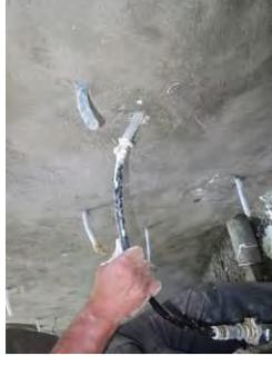
Abdichtung der Kelleraußenwand (li. Fläche egalisiert beim Injizieren; re. mineralische Abdichtung)
