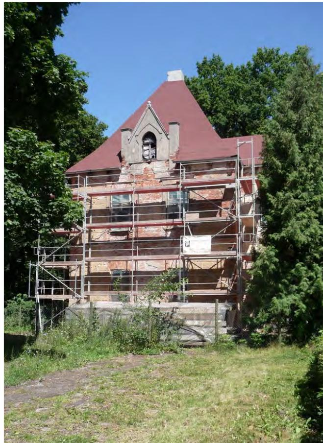
Bild 94. Vollständiges Gerüst
