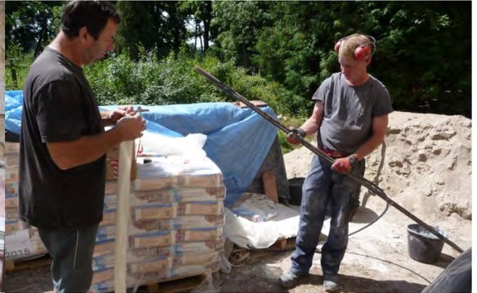
*Bild 104. Vorbereitung eines GFK-Ankers zum Einbau mit Verpressstrecke*
