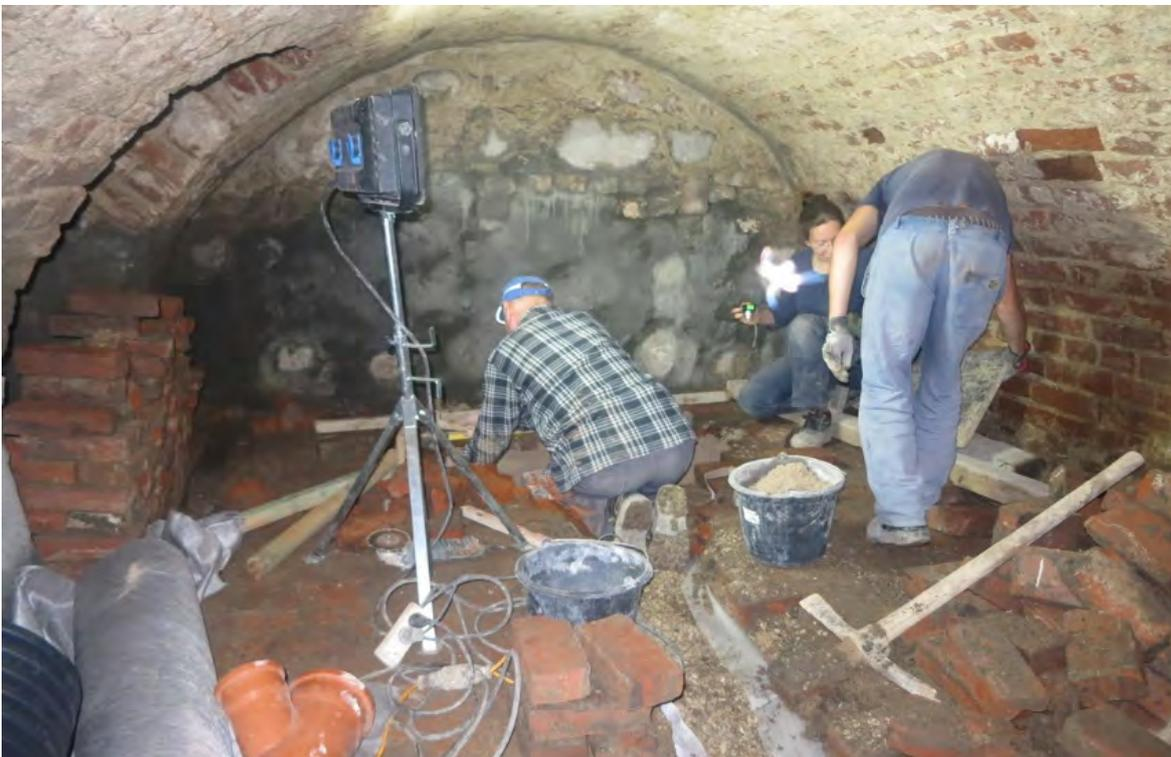
*Bild 261. Verlegung der Altziegel im Mörtelbett*
