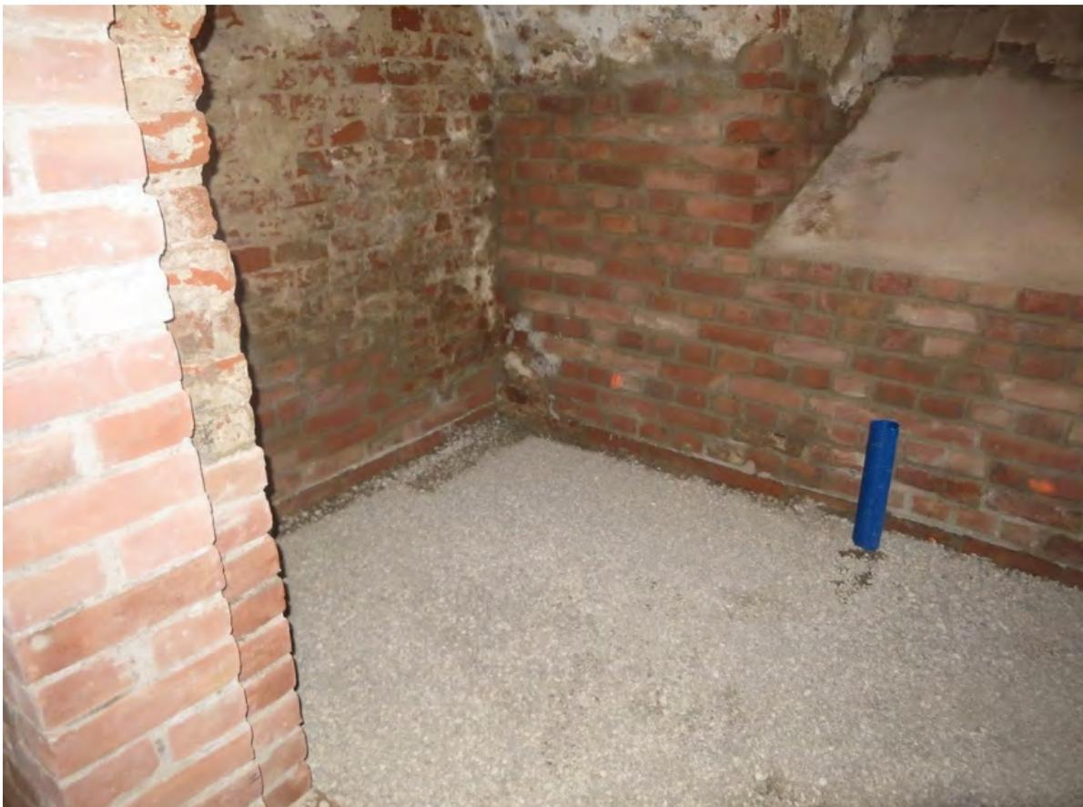
*Bild 259. Anschließende Egalisierung der Kiesschicht (Vlies überlappt mit Deckvlies)*
