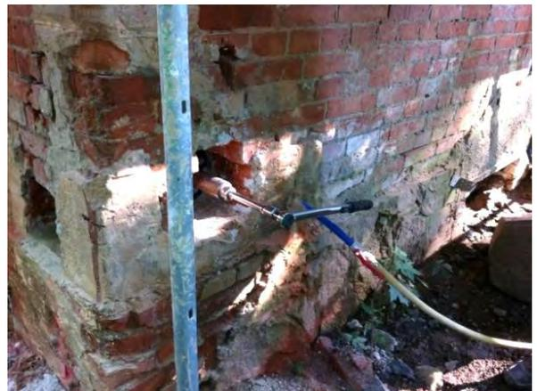
*Bild 106. Anziehen der Anker Mutter ohne Vorspannung*
