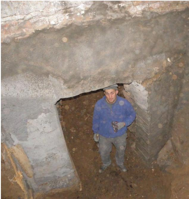
*Bild 178. Fertiggestellte Sicherung der Mittellängswand*
