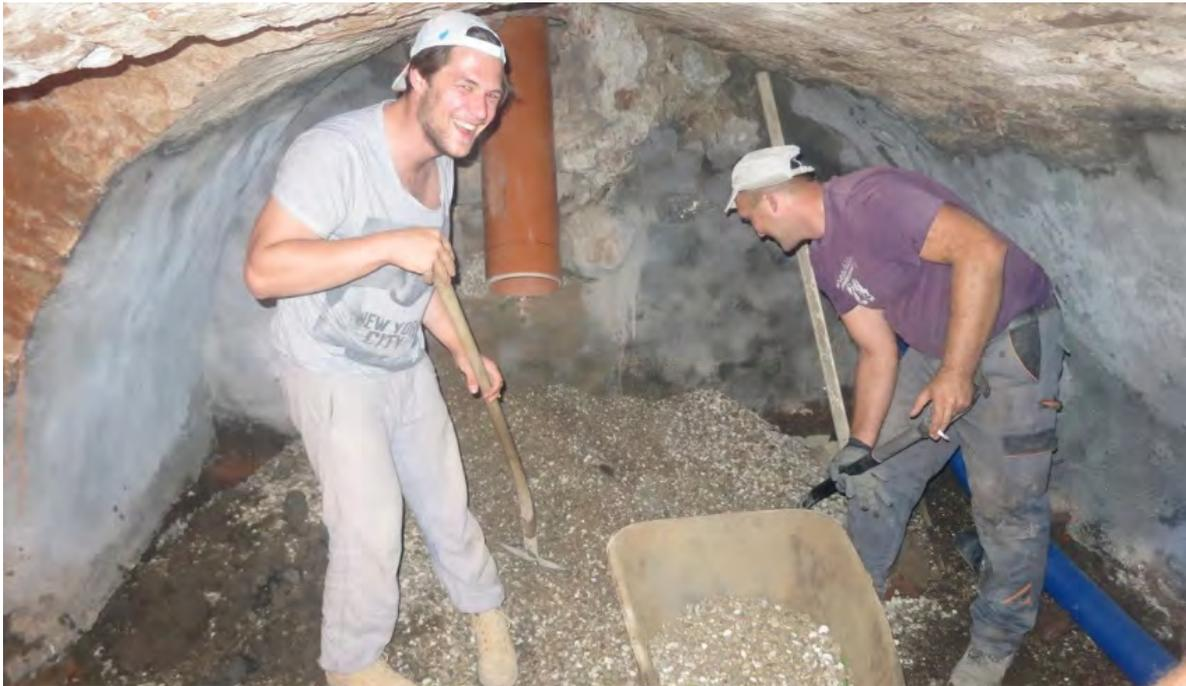
*Bild 258. Ausbringen des Flächenfilters (Filterkies)*
