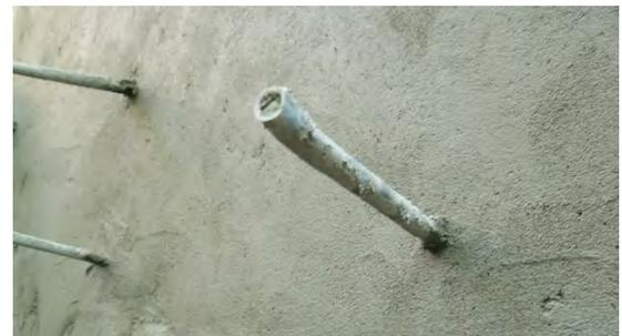
Bild 255. Packer nach dem Glätten der gespritzten Oberfläche
