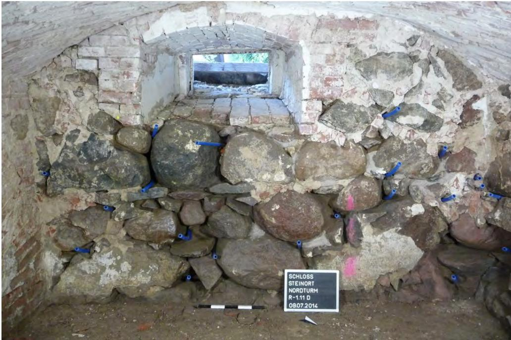
*Bild 100. Einsetzen der Verpressschläuche vor dem Verfugen, Kellermauerwerk im NW-Turm*
