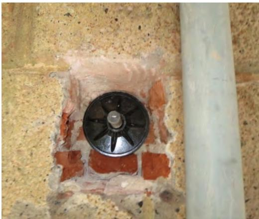
*Bild 105. Endplatte noch unvermörtelt*
