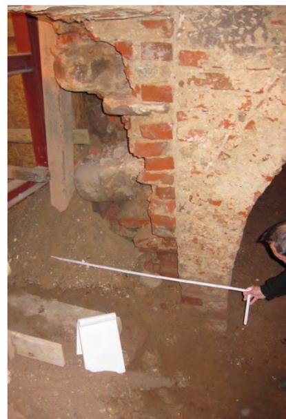
Bild 18. Mauerwerk im Keller; a) Mittellängswand im Keller des NW-Turmes Richtung N, b) Einbruchstelle im Hauptbau (jetziger Durchgang von R -1.05 nach R. -1.01)
