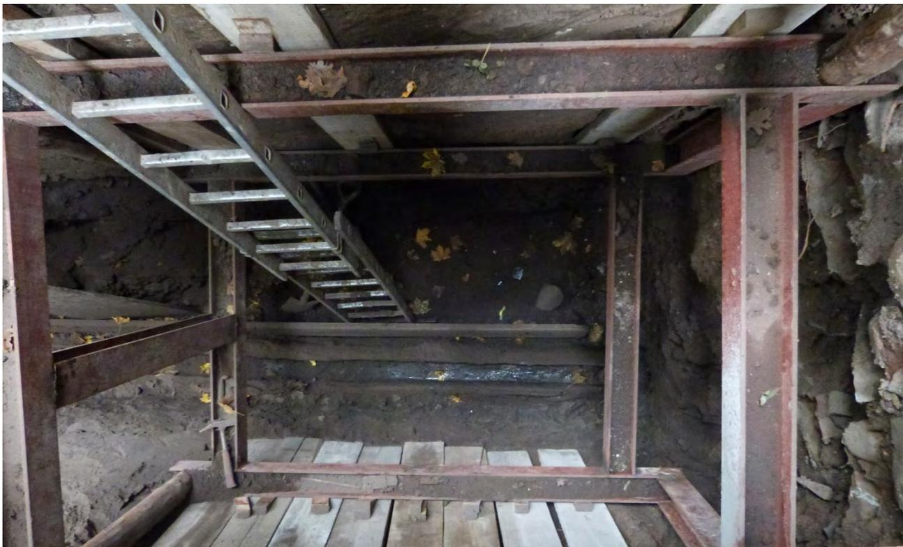
*Bild 309. Notwendiger Schachtverbau für die ca. 4,50 m tiefe Grube*
