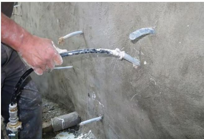
Bild 256. Packer eingekürzt, Rundstab gezogen, Verpressrüssel mit Schlauchklemme befestigt
