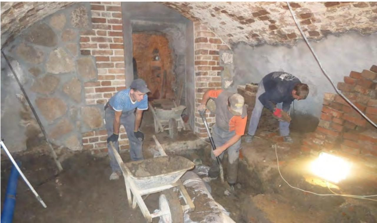
*Bild 257. Ausheben der Dränrohrgräben und Abtransport des Aushubs*
