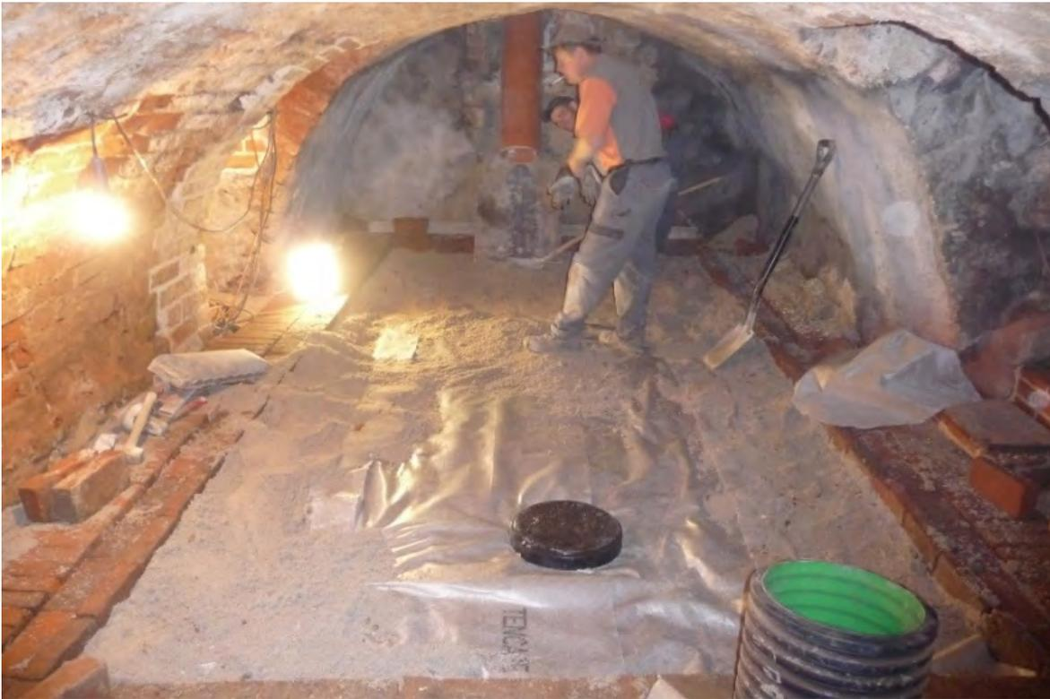
*Bild 260. Auslegen des abdeckenden Filtervlieses*
