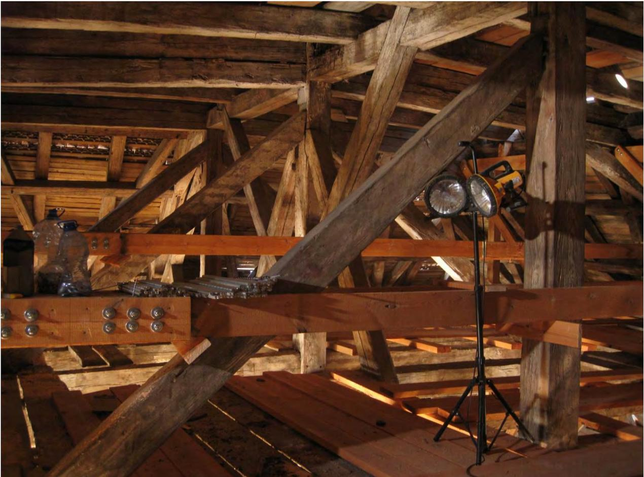
*Bild 14. Blick in die Dachkonstruktion (1. Dachgeschoss), im Vordergrund die Zangen zur Sicherung mit den Bolzenverbindungen*
