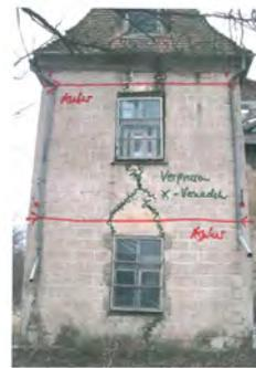
Bild 33 Variante dauerhafte Sicherung
