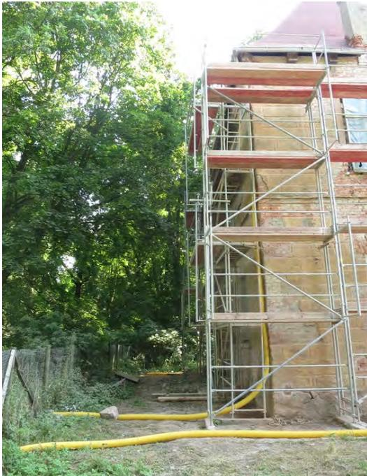
*Bild 319. Provisorische Regenwasserableitung mittels gelber Ripprohre FF-Drähn ungeschlitzt am NW-Turm*
