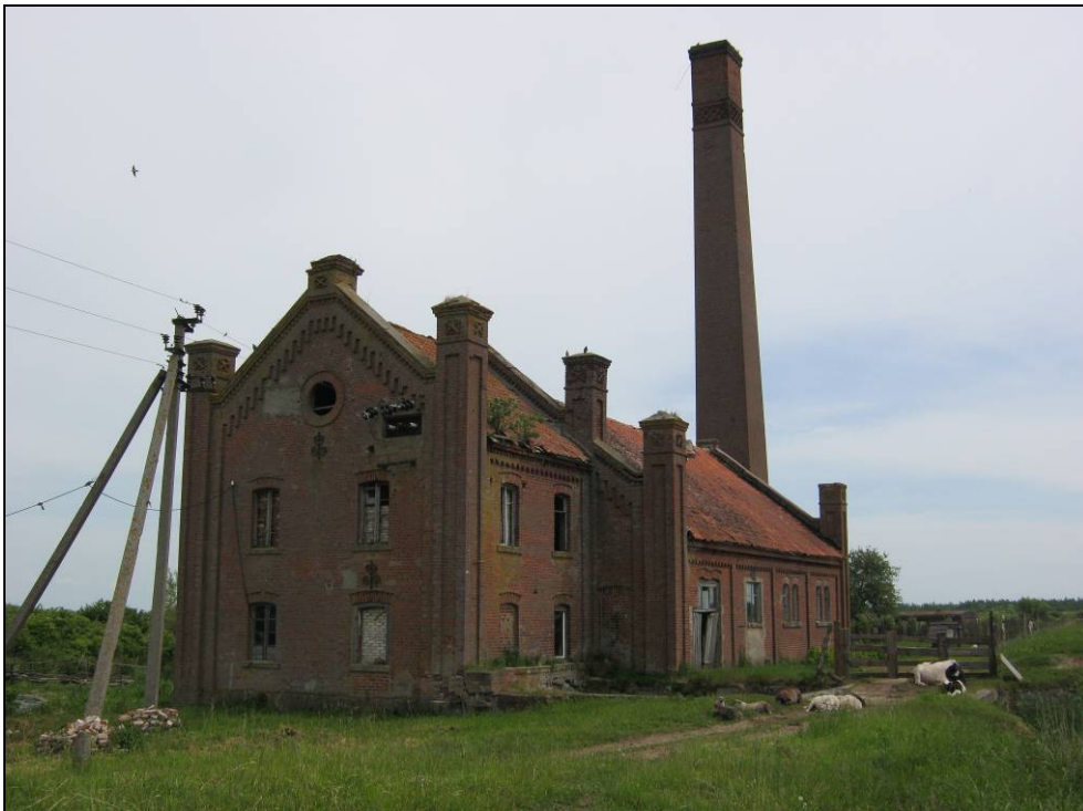
Abb. 74: Altes Schöpfwerk Nr. 38 am Fluss Nemoninka, 1872 erbaut. Foto: Napreenko, MG
