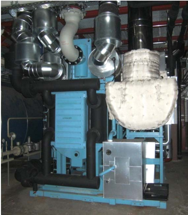
Abbildung 4: Sonderanfertigung der zwei-/einstufigen AKM mit externer Kopplung
