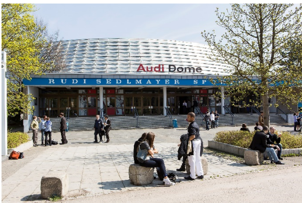
Außenansicht Audi Dome
