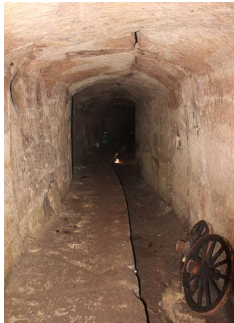
Abbildung 7: Blick in den Rappen-Keller Richtung Süden
