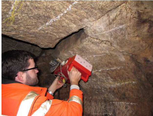
Abbildung 2: Zur Messung wird der 900 MHz Sensor an den Wandflächen entlang geführt.
