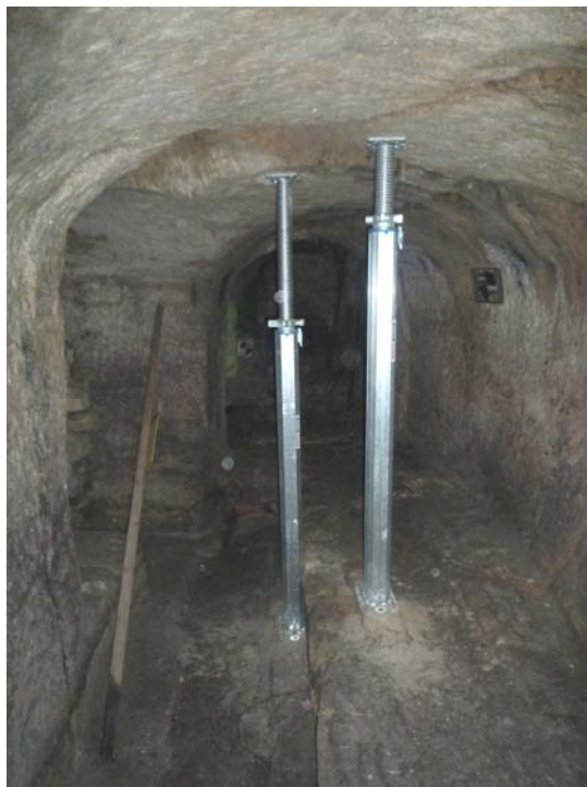
Abbildung 11: Schwerlaststützen aus Aluminium sichern große Felssegmente.
