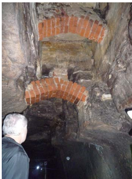
Abbildung 3: Historische Bogenkonstruktion im Weiß-Tauben-Keller.
