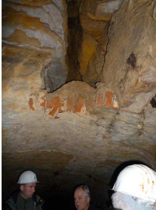
Abbildung 12: Ziegelgewölbe mit darüber liegendem, nicht verfülltem Hohlraum.
