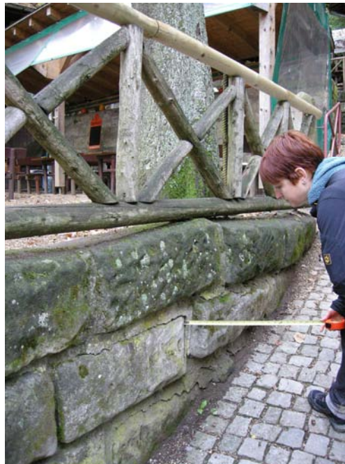
Abbildung 7: Hier kann der Baum erhalten werden, wenn auf die Mauer im vorderen Bereich verzichtet wird, d.h. Natursteine entfernt werden. Eine Situation, wie in Abbildung 5 könnte entstehen.
