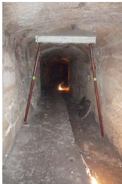
Abbildung 11: Schrägstützen mit Querträger im Rappenkeller.
