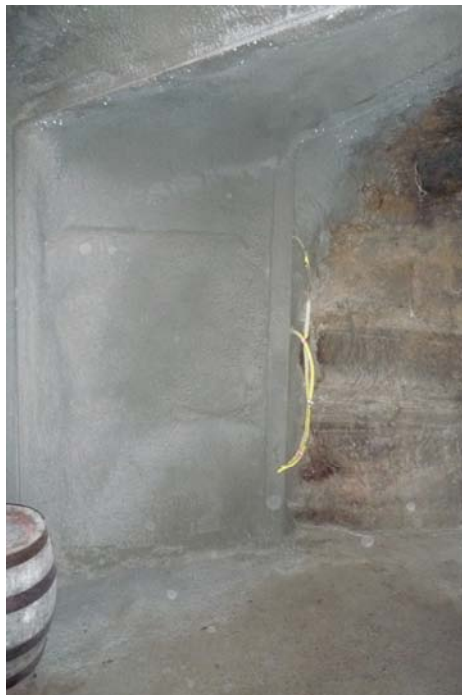
Abbildung 7: Mit Spritzbeton verkleidete Wand im Schwanenkeller im Kellerwald Forchheim.
