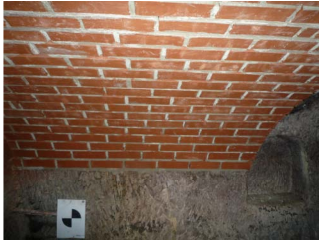
Abbildung 17: Neues Ziegelgewölbe im Weiß-Tauben-Keller. Phot Rolf Snethlage
