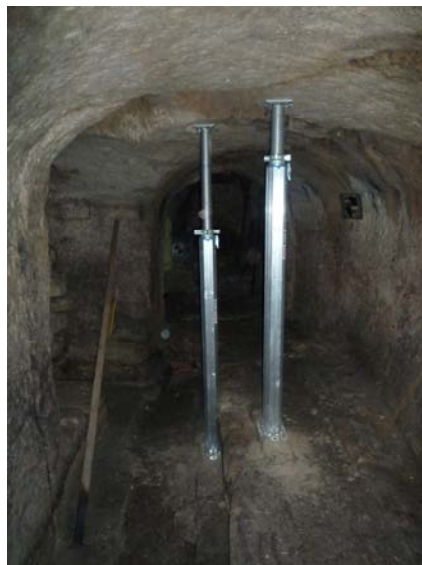
Abbildung 16: Schwerlaststützen aus Aluminium sichern große Deckenteile im Bauernkeller. Photo Rolf Snethlage
