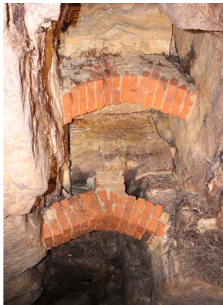
Abbildung 13: Ziegelbogenkonstruktion im Deckenbereich des Nordgangs
