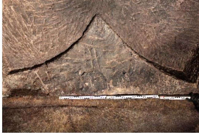
Abbildung 18: Abarbeitung im Deckenbereich (Blick von unten)
