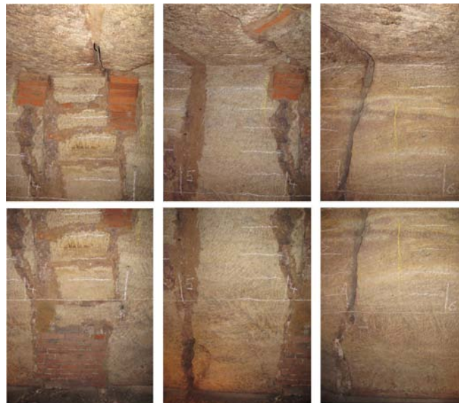
Abbildung 14: Rappenkeller, Situation an der rechten Wand zwischen y = 4,0 - 7,0 m
