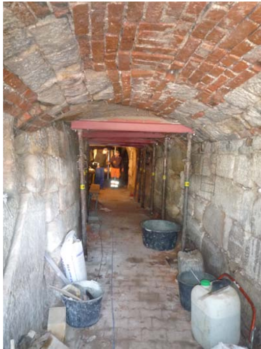
Abbildung 10: 6 Schrägstützenpaare sichern den Eingangsbereich des Bauernkellers.
