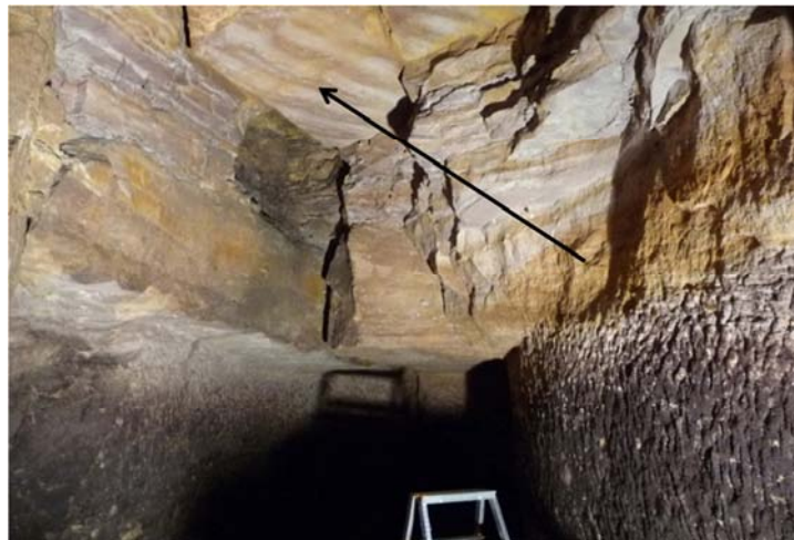
Abbildung 17: Westliche Fazies, Einsturzbereich am Ende des Hauptganges. Auf den ausgearbeiteten Werksandstein folgen ohne markante Trennschicht feinere, geschichtete Sandsteine mit grauen Glimmerzwischenlagen. An den durch einen Abbruch freigelegten Trennflächen sind die Rippelmarken der strandnahen Sedimentation zu erkennen (Pfeil).
