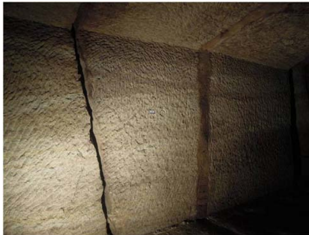
Abbildung 4: Felswand im Rappenkeller mit schräg geschichtetem, kompaktem Sandstein ohne trennende Schichtgliederung. Die weit stehende Klüftung des Sandsteins wurde vielfach mit Mörteln verschlossen.
