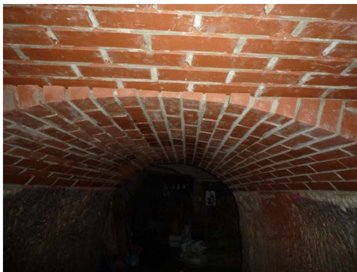
Abbildung 5: Neues Ziegelgewölbe im Weiß-Tauben-Keller.
