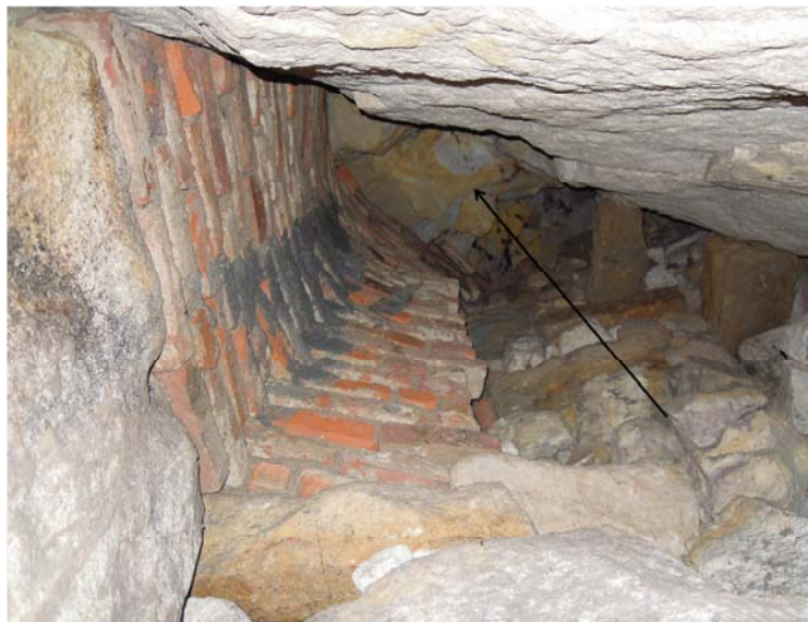
Abbildung 12: Blick nach oben in den mit Ziegelausmauerung gesicherten Versturzbereich. Im Hangenden stehen instabile Wechsellagerungen aus beigen Feinsanden und grauen Tonen an. Die Höhenlage dieser Schichten beginnt etwa bei vier Meter über dem Stollenboden. Der gesamte Ausbruch reicht bis in sechs Meter Höhe.
