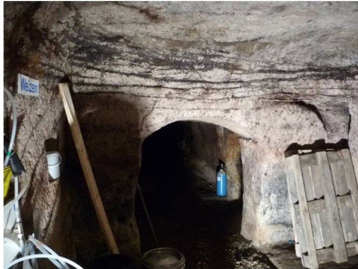
Abbildung 16: Östliche Fazies der Übergangsschichten im nördlichen Begleitgang. Der Durchgang bleibt im Bereich des Werksandsteins. Der Raum selbst ist über die markanten, schwarz ausbleibenden Tonlagen hinweg bis an eine grobkörnige, stabile Sandsteinlage gearbeitet.
