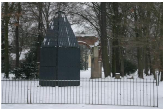
Abb. 58 Park Dessau-Wörlitz, Luisium, Stahlgerüst mit Metalldachpfannen
