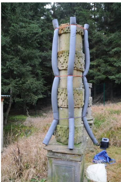
Abb. 27 Anbringung Distanzhalter
