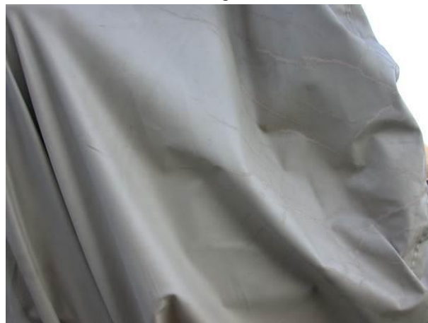
Abb. 76 Schloss Moritzburg, Materialermüdungserscheinungen
