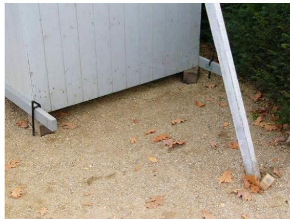
Abb. 90 Sicherung mit Erdnägeln
