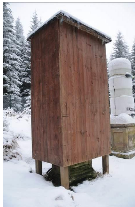
Abb. 16 Holztafeleinhausung am Objekt Herbst
