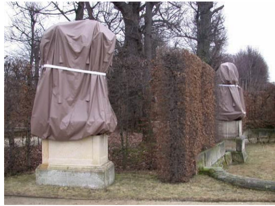
Abb. 78 Barockgarten Großsedlitz, textile Einhausung von Doppelfiguren
