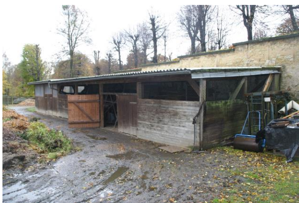
Abb. 138 Schuppen für die Sommerlagerung der Holztafeln
