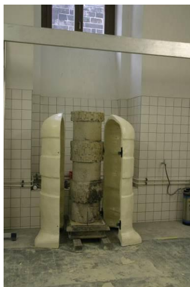
Abb. 42 Einbringen der Schließungen
