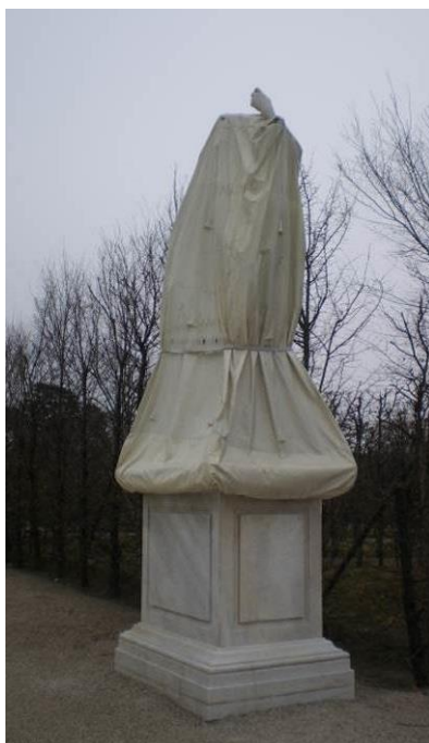
Abb. 107 geöffnete Naht/Riss im oberen Bereich der Textil- hülle, Foto: ©Haselberger
