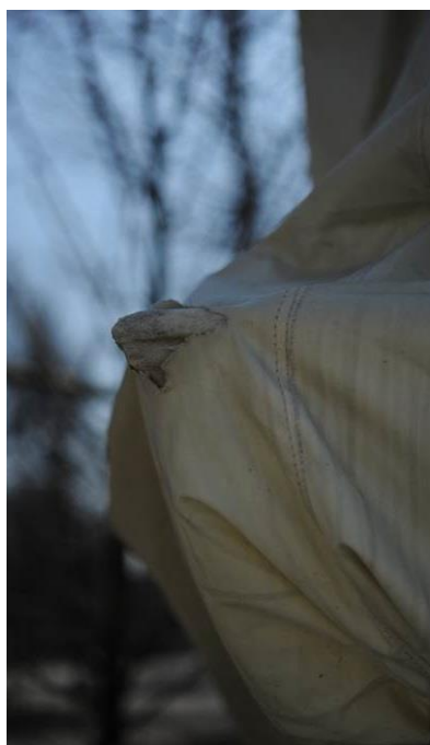
Abb. 109 Lochbildung infolge fehlen- dem Reibungsschutz der Ecke, Foto: ©Haselberger
