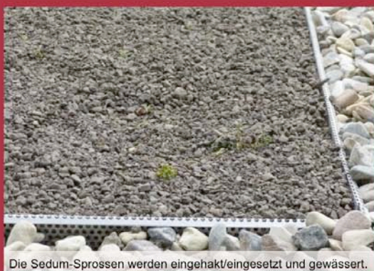
Die Sedum-Sprossen werden eingehakt/eingesetzt und gewässert.
