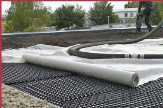
Auf die Abdichtung kommen ein Schutzvlies und Drainagematten.
