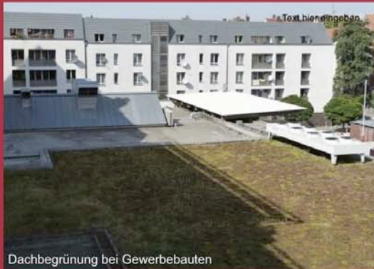
Dachbegrünung bei Gewerbebauten
