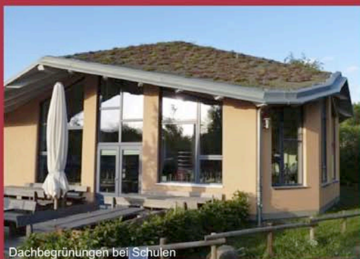
Dachbegrünungen bei Schulen
