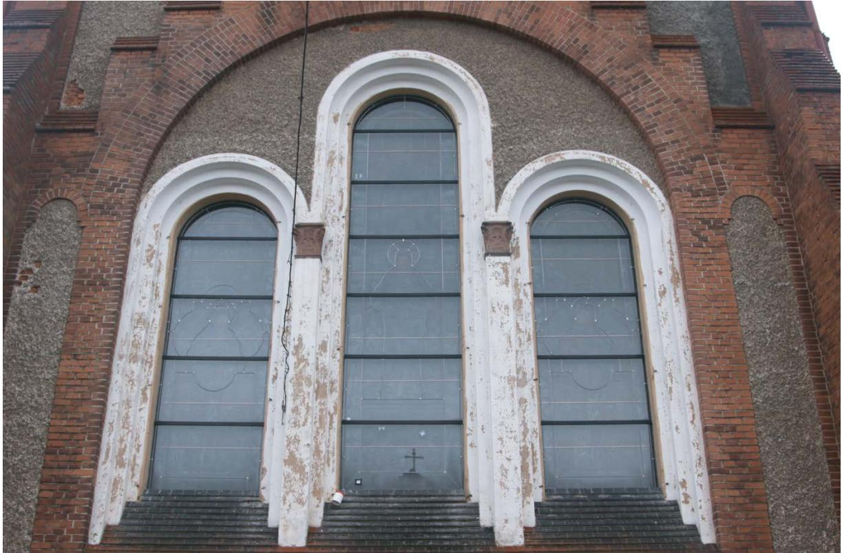
Bild 13: Außenschutzverglasung an den Fenstern nIV, nV und nVI
