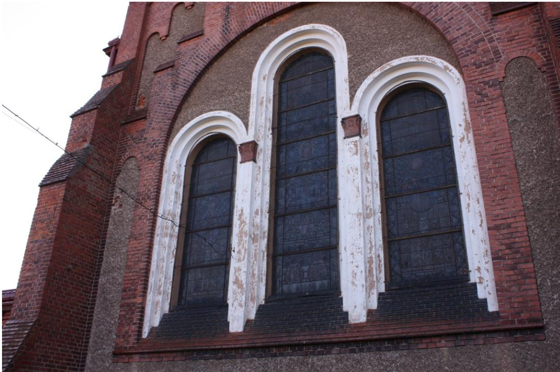
Bild 2: Außenansicht mit Drahtgitter als Schutz an den Fenstern nIV, nV und nVI
