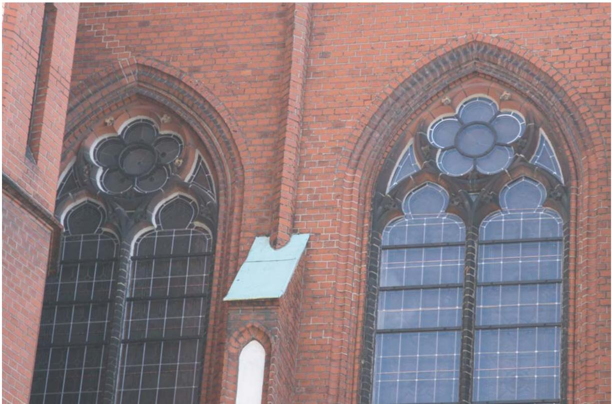
Bild 24: Außenansicht der neuen Schutzverglasung
