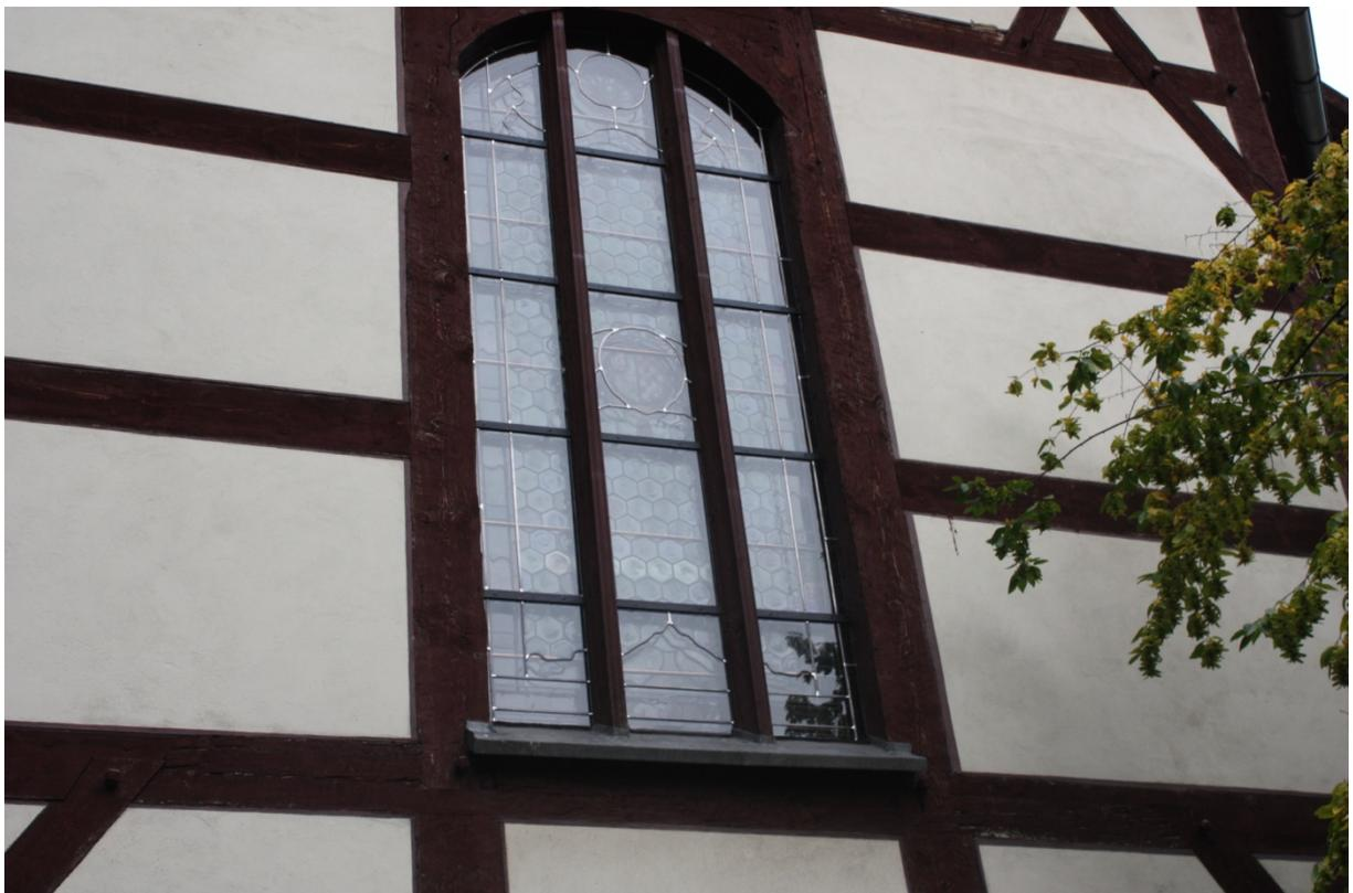
Bild 32: Fenster I mit neuer Außenschutzverglasung
