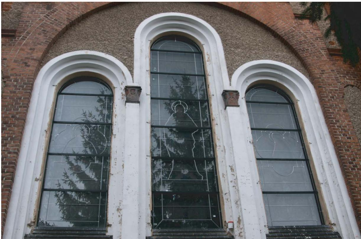
Bild 11: Außenschutzverglasung an den Fenstern sIV, sV und sVI
