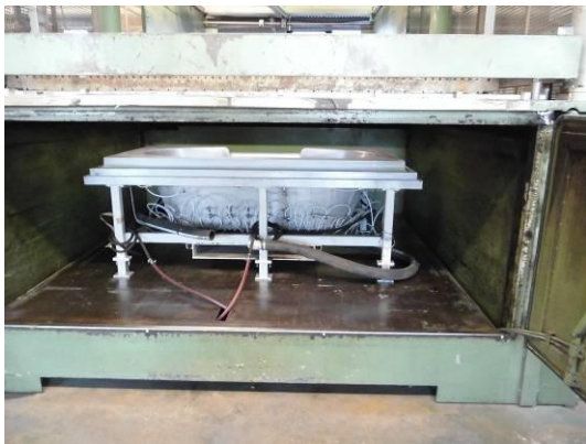
Abbildung 1: Einbau der Aluminiumform in der Tiefziehmaschine
