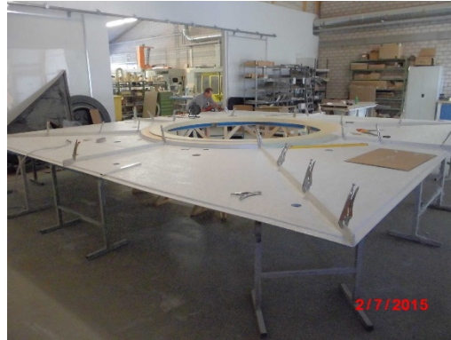
Dach für ein großes Dampfbad
