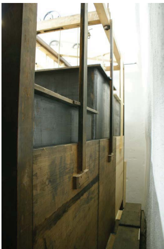
Abb. 42 Balganlage Hinterseite mit rekonstruiertem Kastenbalg
