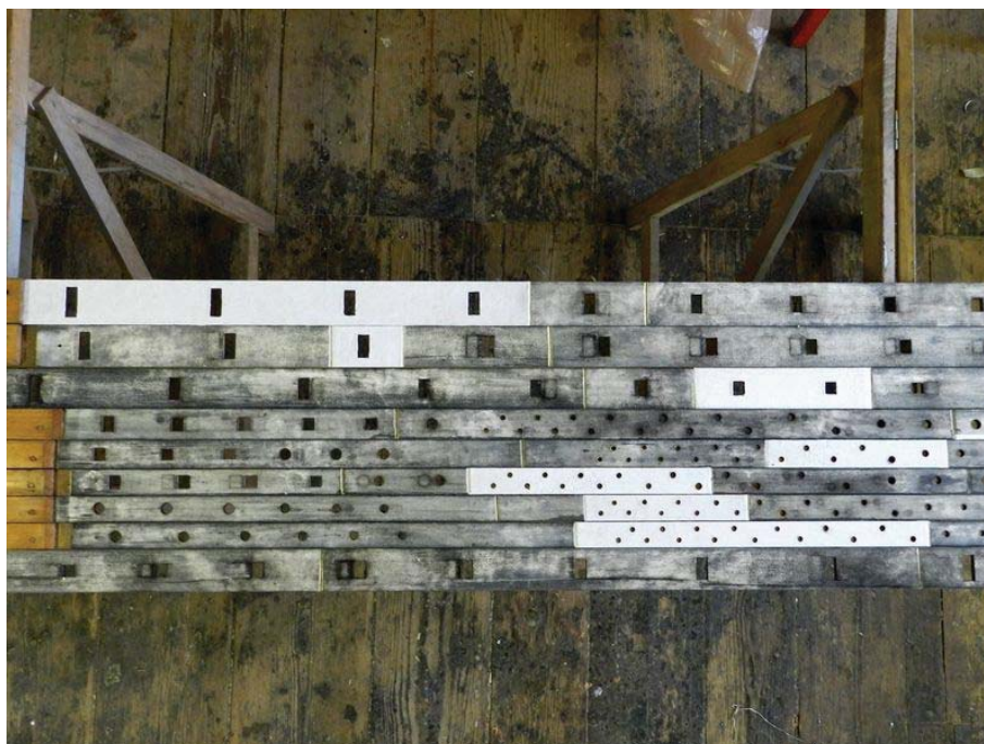
Abb. 19 Partiiell erneuerte Schleifenbeledungen
