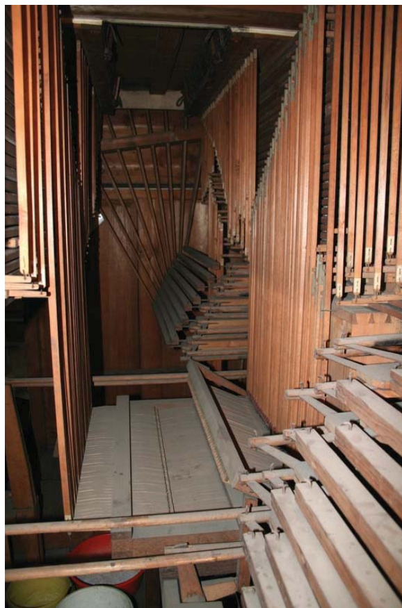
Abb. 28 Blick in die Tontraktur vor der Restaurierung
