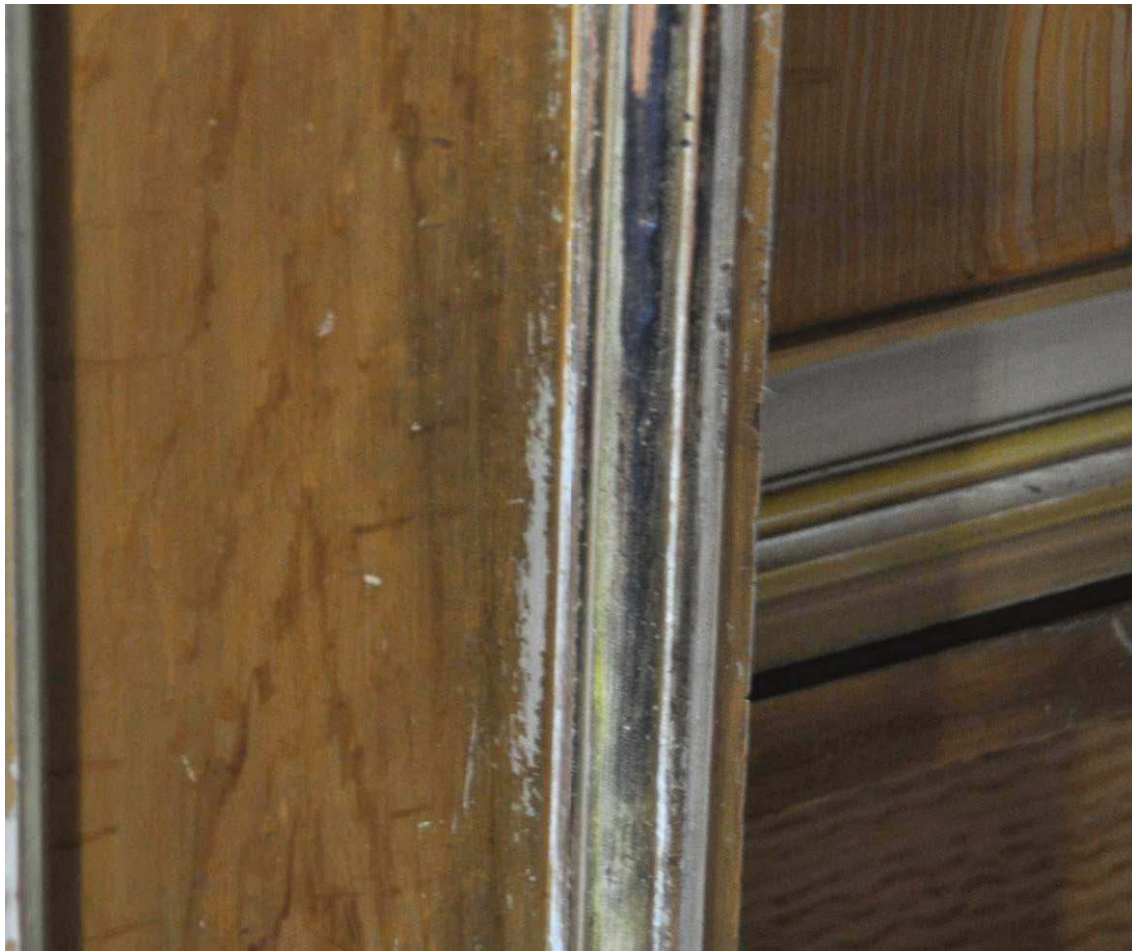
Starke Gebrauchsspuren, Totalabrieb an einigen Profilleisten
