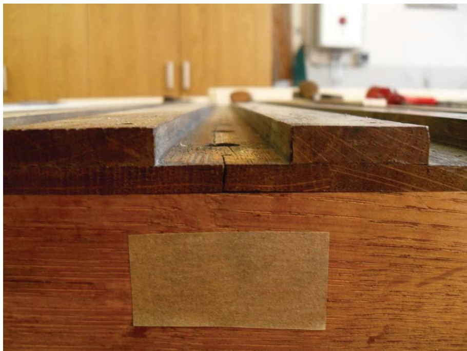
Abb. 14 Rissbildung im Schleifenbereich mit Ablösungserscheinungen der Fundamentplatte
