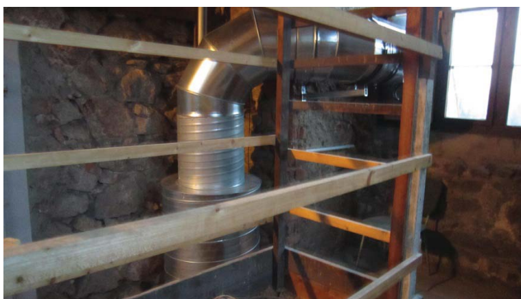
Abbildung 10: Ablufteinrichtung durch die Wand hinter der Orgel nach außen
