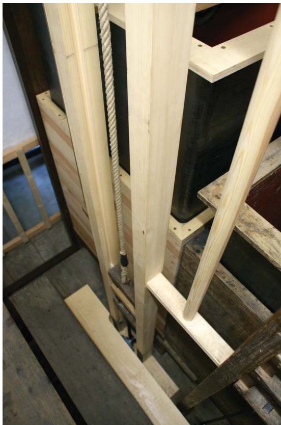
Abb. 49 Rekonstruierter Kastenbalg in aufgezogenem Zustand
