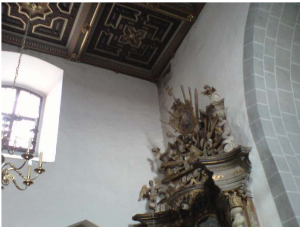
Abbildung 50: Anschluss Decke Außenwand/Innenwand neben Eingangsbereich (4,1°C)
