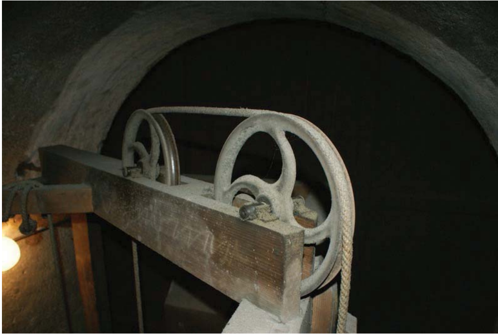
Abb. 43 Seilzugrollen in vorgefundenem Zustand
