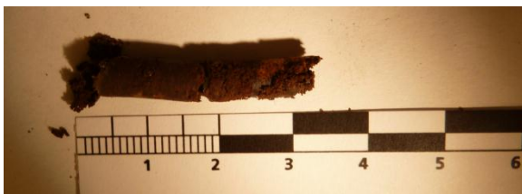
Abb. 40: Poröser, brüchiger und mit Carbolineum durchtränkter Bohrkern.
