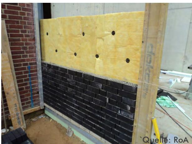
Abb. 44: Neubau Außenwand Klinker
