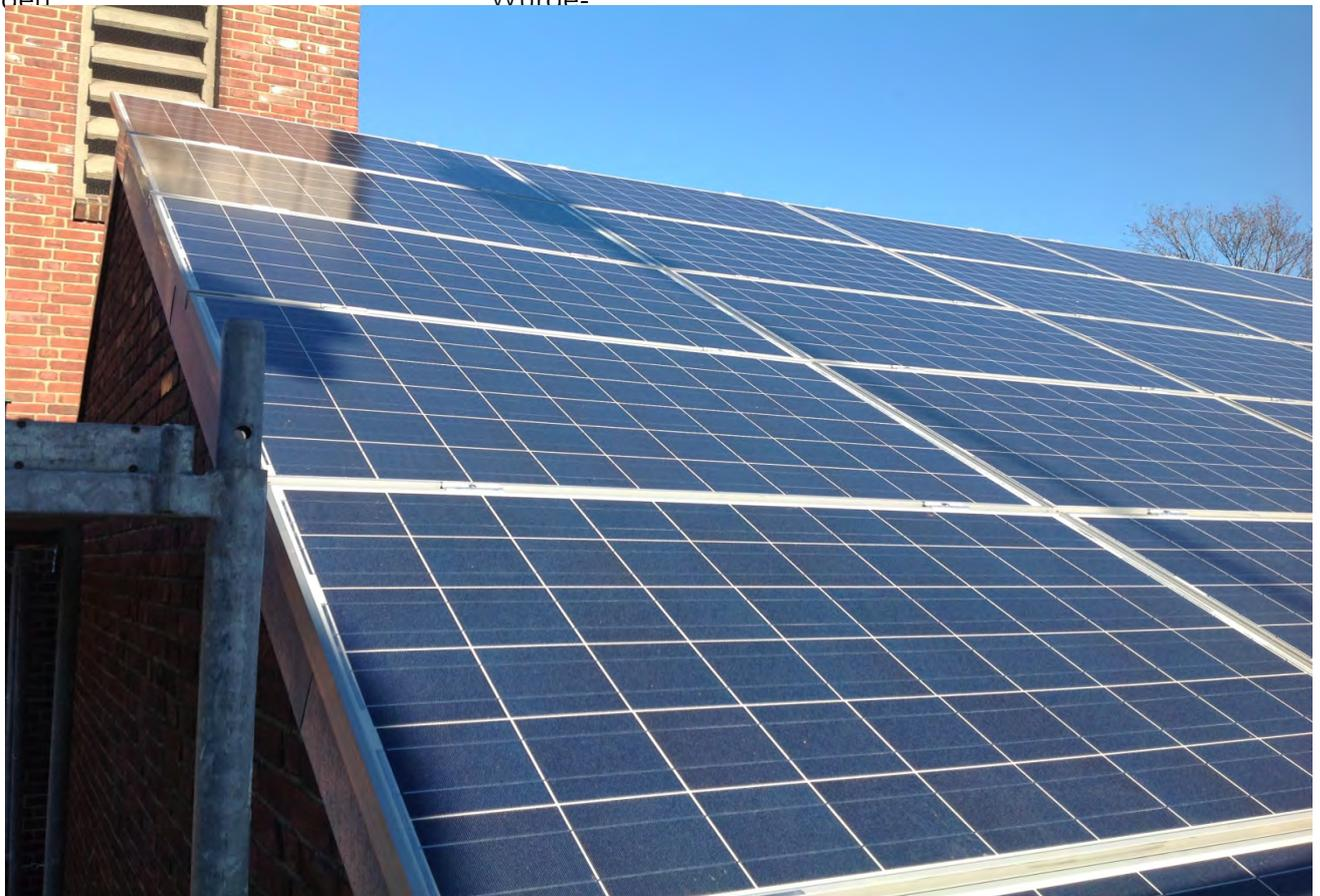
Abb. 60: Indach-PV-Anlage
