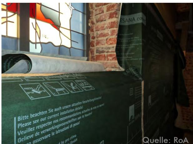
Abb. 40: Feuchteadaptive Dampfbremsbahn
