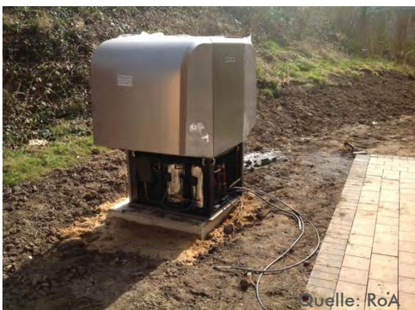
Abb. 71: Wärmepumpe in Außenaufstellung
