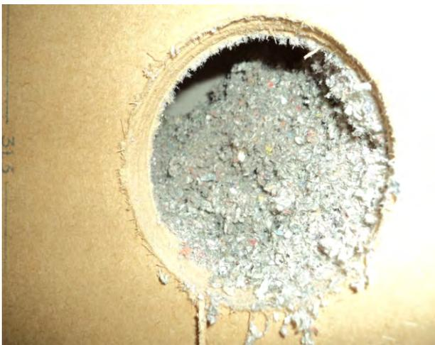
Abb. 37: Einblasöffnung Zellulosedämmung
