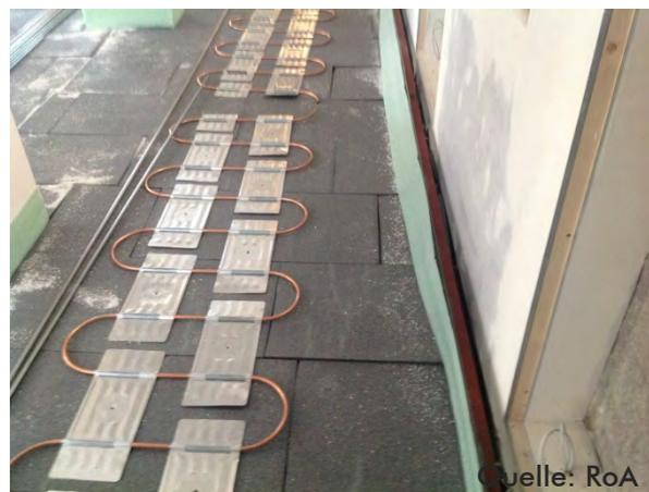
Abb. 73: Heizschlangen der Fußbodenheizung
