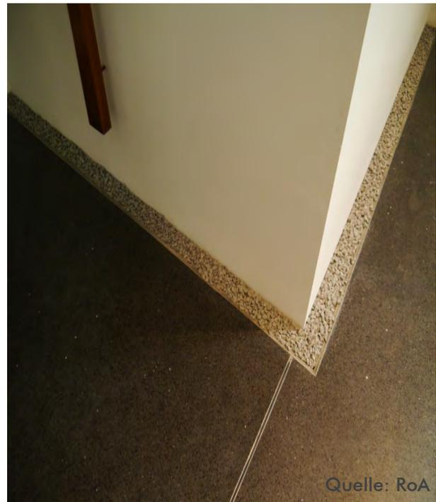
Abb. 50: Bodenrandabschluss Kiesstreifen
