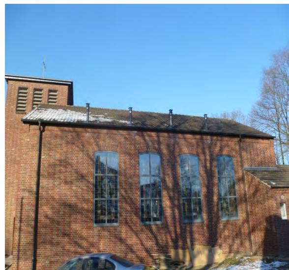
Abb. 14: Abgasführung der inneren Heizöfen
