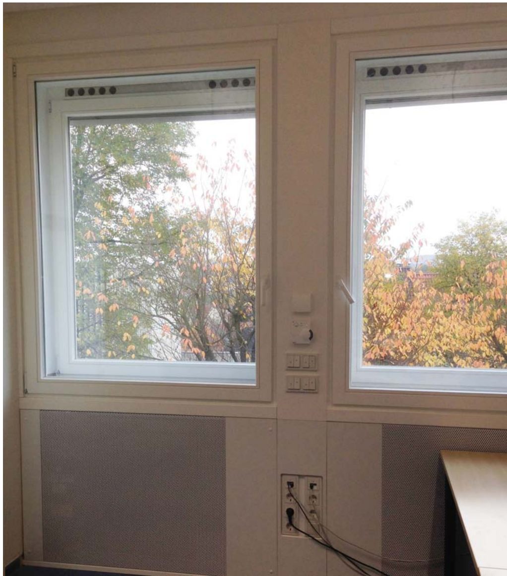
Musterraum mit dem neuen Kastenfenster. Hinter dem Stahlgitter auf der linken Seite befindet sich das Lüftungsgerät. Das Stahlgitter auf der rechten Seite ist zum ästhetischen Gleichklang da.
