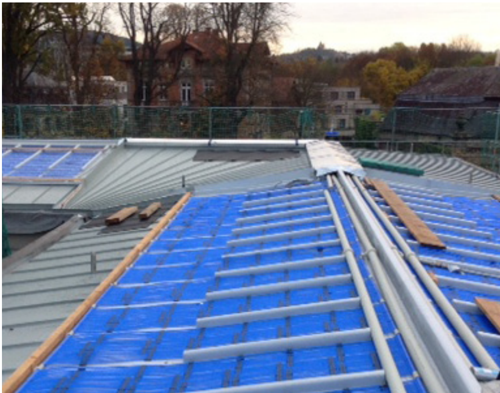
Kapillarmatten vor der Verlegung der Polycarboantplatten. unten: die Glykolrohre liegen unter der Firstab deckung
