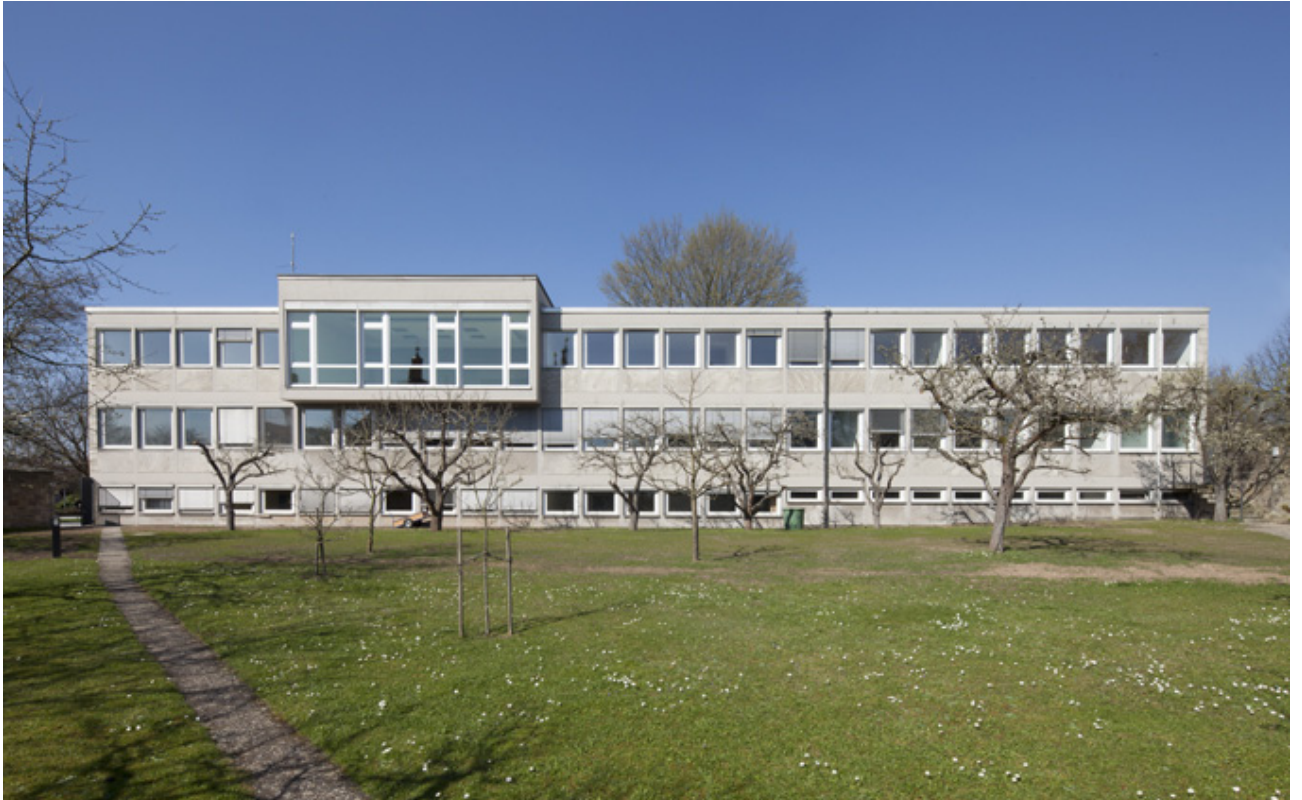
Südseite vom Bischofsgarten aus gesehen. Alter Zustand vor der Sanierung
