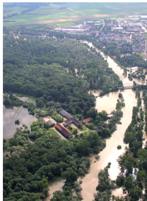
Nur per Boot erreichbar: Das Hochwasser vom Juni 2013 verzögerte in Guntershausen die Bauarbeiten, zeigte aber auch die Notwendigkeit einer hochwasserangepassten Planung.
