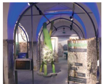
Lichtinszenierung: Über LED-Bänder entlang der Stahlbögen lässt sich das Gewölbe farblich illuminieren.
