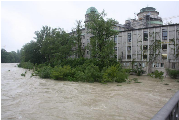
Abbildung 1: Blick von der Zenneckbrücke auf das Deutsche Museum während des Hochwassers 2013. Die Zenneckbrücke liegt auf dem Weg zur Probenahmestelle. Die Gruppen können so die aktuelle Situation direkt mit der Hochwassersituation vergleichen.
