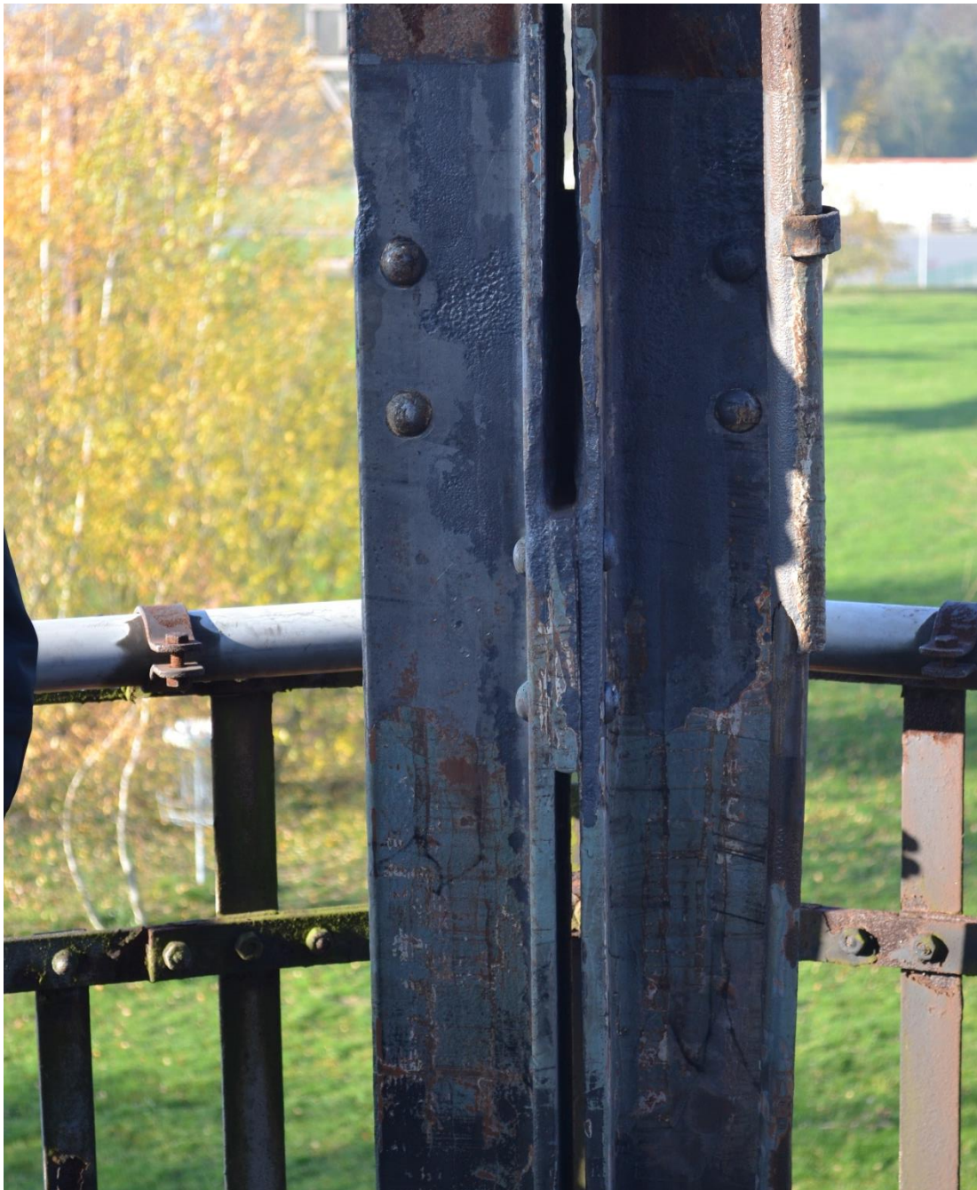
Oberfläche nach der Reinigung mit dem Laser, Foto: HIG – Hempel Ingenieure GmbH
