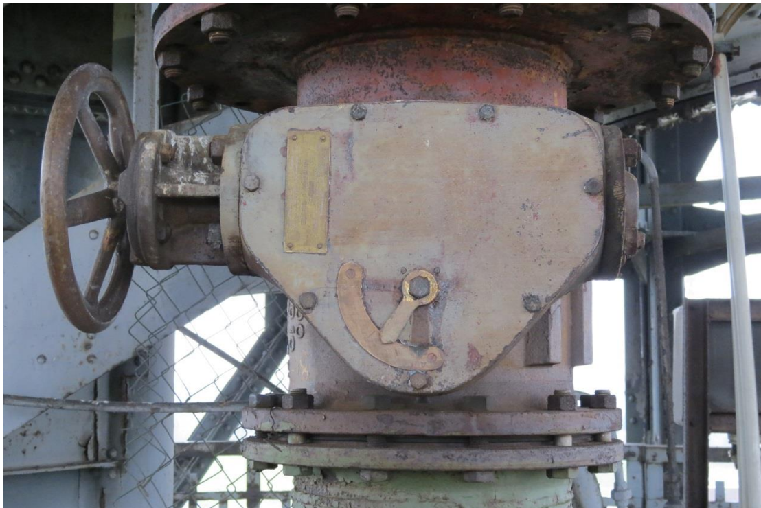
Gereinigte Oberfläche mit Wachs versiegelt, Foto: HIG – Hempel Ingenieure GmbH
