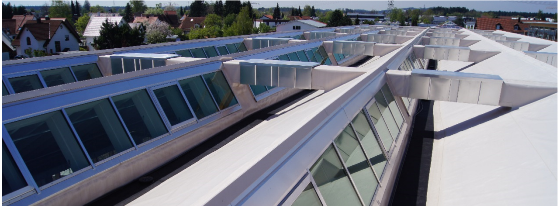
Abbildung 2 – Sheddach mit Fensterband (Nord) und weißer Dachfolie (Süd)
